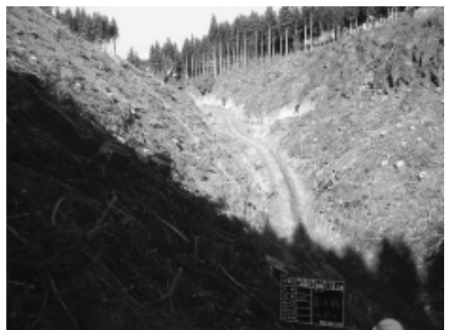
写真-2 工事着工前②
