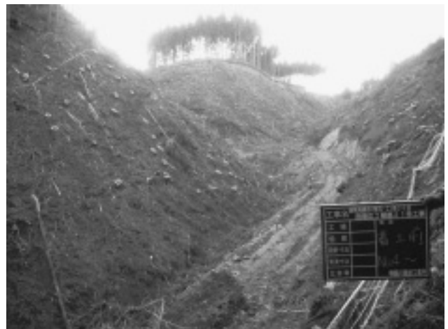
写真-1 工事着工前①
