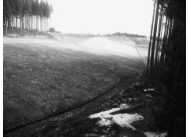
写真-6 盛土部完成
