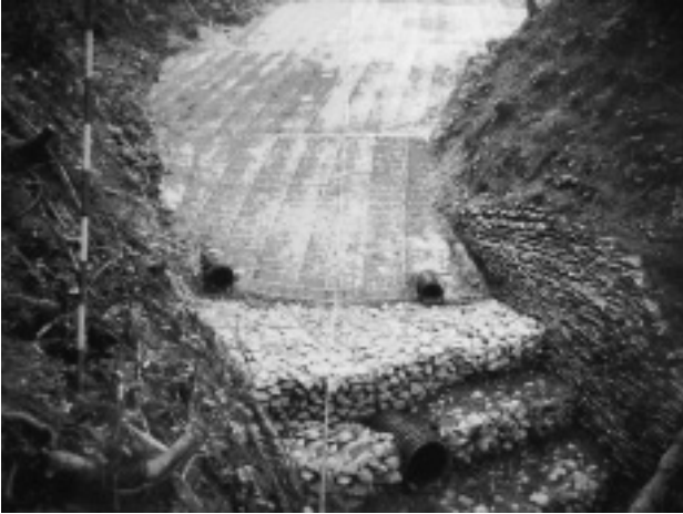
図-5 法面部完成
