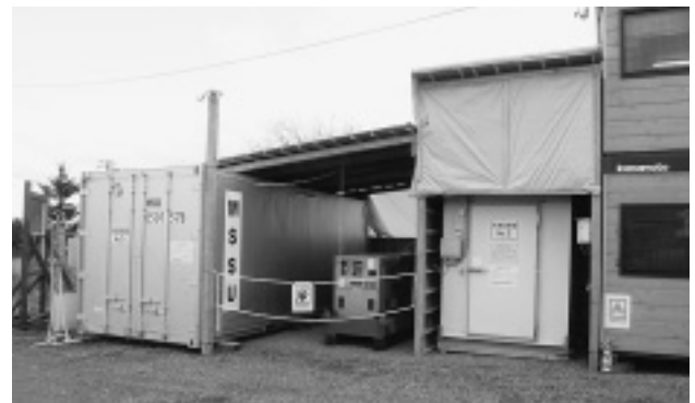
写真-2 No.2,3 試験用冷凍庫
