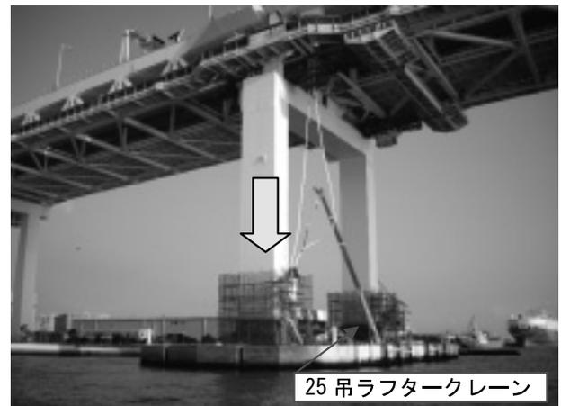
写真-7 ケーブル下端架設状況
