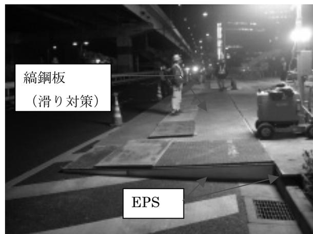
写真-3 EPS 及び縞鋼板
