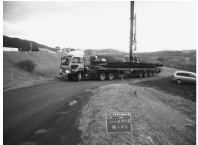
写真-3 大型トレーラーによる運搬
