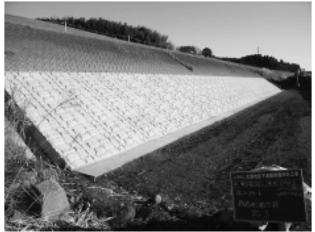
写真-6 完了写真（終点側より）
