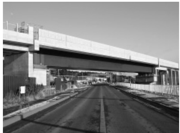
写真-4 完成写真
