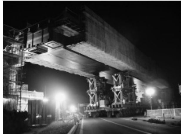
写真-3 一括架設状況
