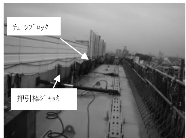
写真-2 チェーンブロックとジャッキ
