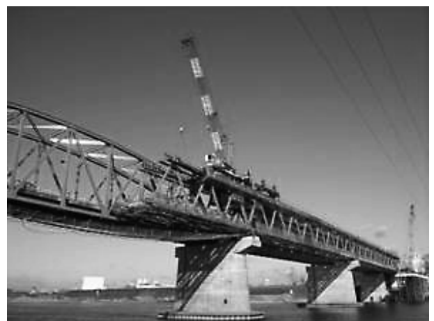
写真-2 トラベラクレーン架設
