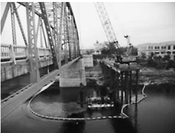
写真-4 杭施工時の河川汚濁対策
