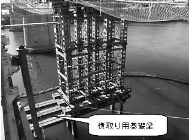
写真-3 ベント横取り用基礎梁
