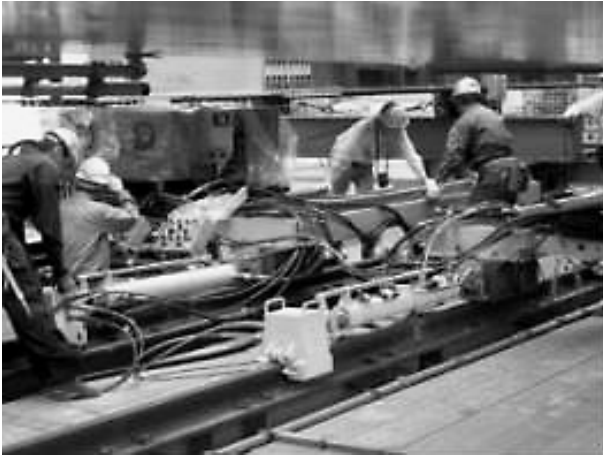
写真-1 ツインジャッキシステム
