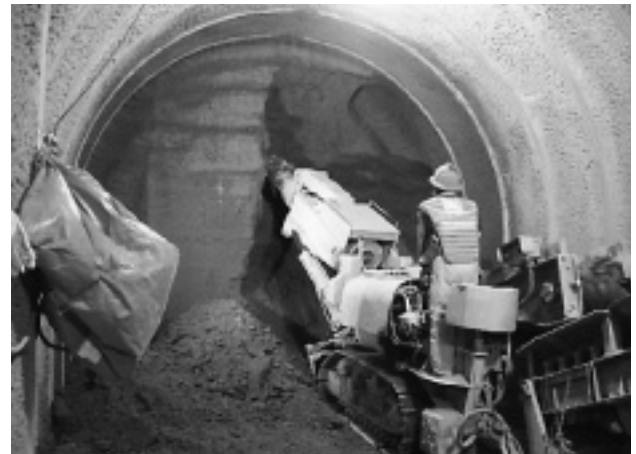
写真-2 ウエルポイント区間の掘削状況
