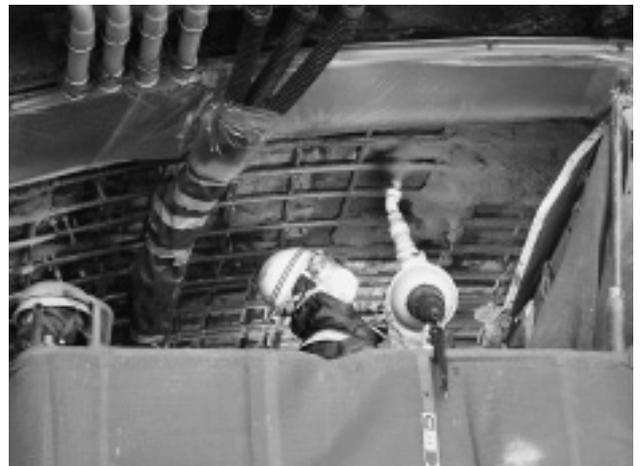
写真-6 TDR ショット吹付け作業
