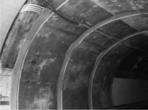
写真-7 覆工コンクリート補強 (完成)
