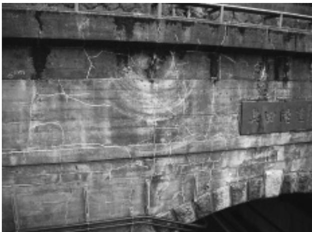
写真-2 坑口構造物（面壁）の変状
