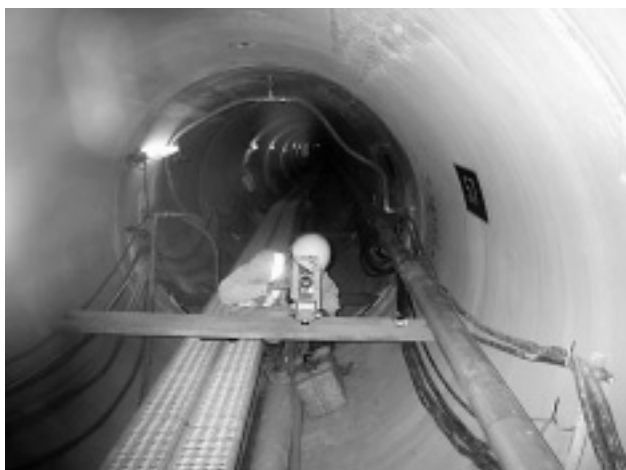
写真-2 測量状況
