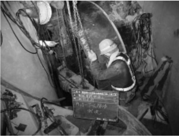
写真-4 掘進機解体状況
