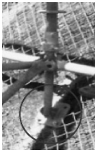
写真-3 ジャッキ固定状況 (角度自在型)
