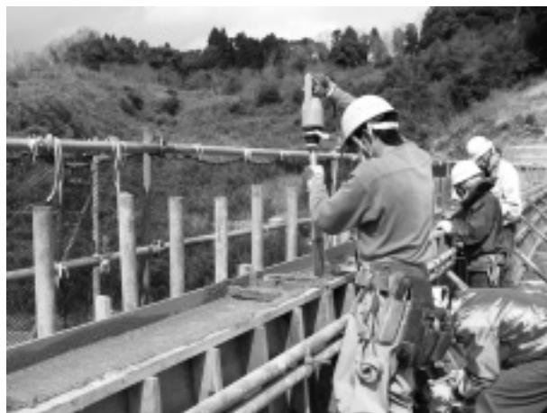
写真-4 コンクリート打設状況
