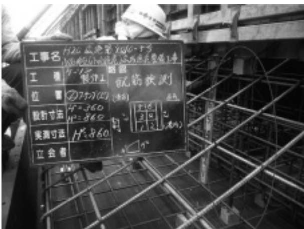
写真-3 スペーサー付鉄筋配置状況
