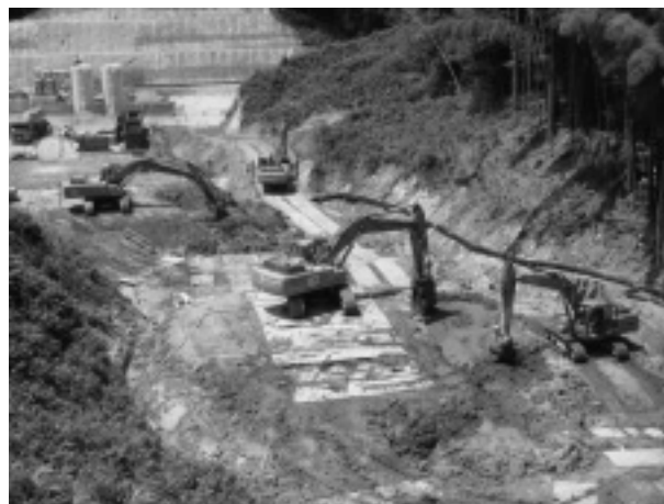
写真-3 改良状況(2パーティー)
