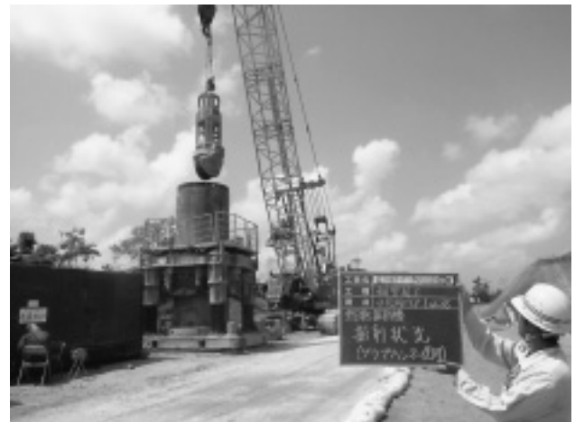
写真-1 全回転型オールケーシング掘削状況
