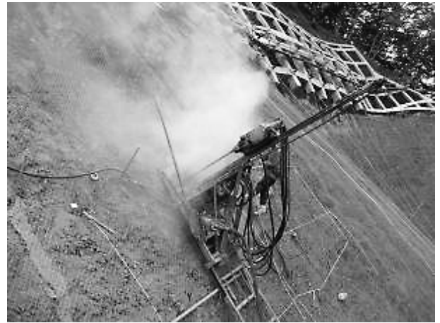
写真-4 ロックボルト施工状況
