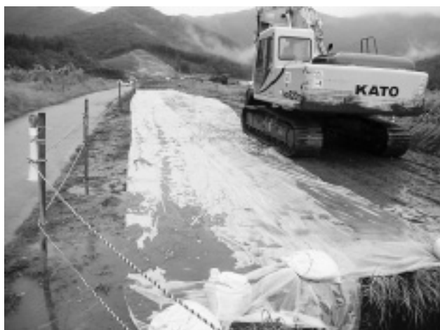
写真-5 降雨流下箇所ビニールシート敷設 (工事用道路箇所)
