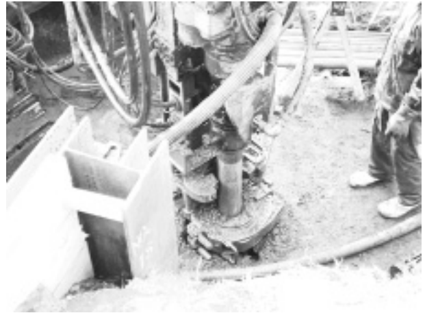
写真-1 親杭削孔状況
