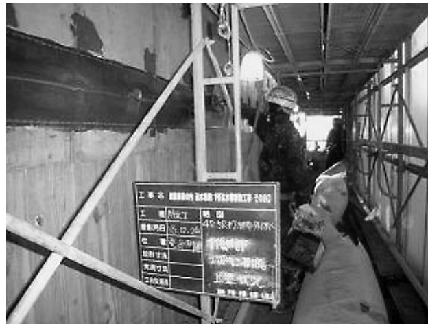
写真-4 外面防水施工状況
