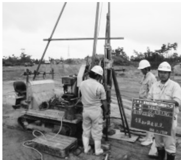
写真-3 隣接工区盛土部での調査ボーリング
