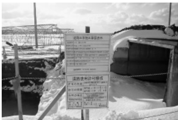
写真-7 道路工事施工承認表(つがる市) 道路使用許可票(つがる警察署)
