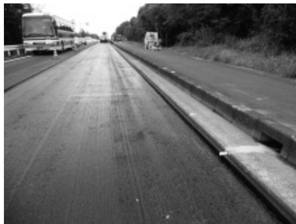
写真-3 基層工舗設前
