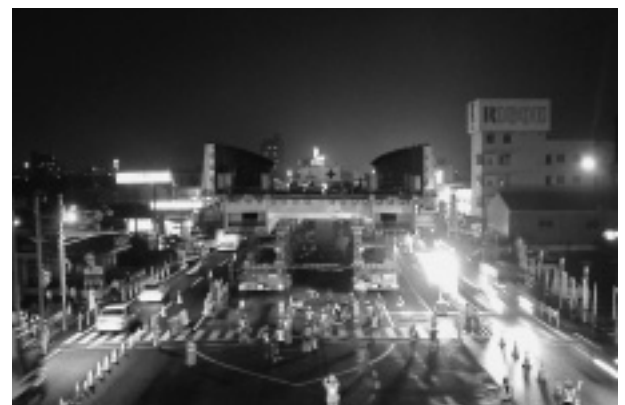
写真-1 P3-P4架設
