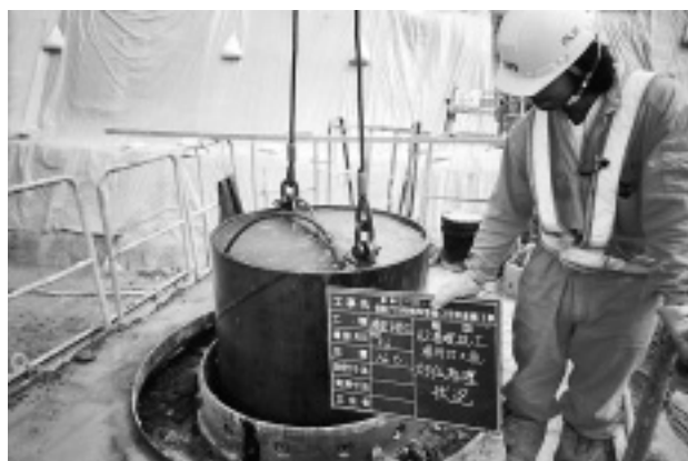
写真-2 スライム処理状況
