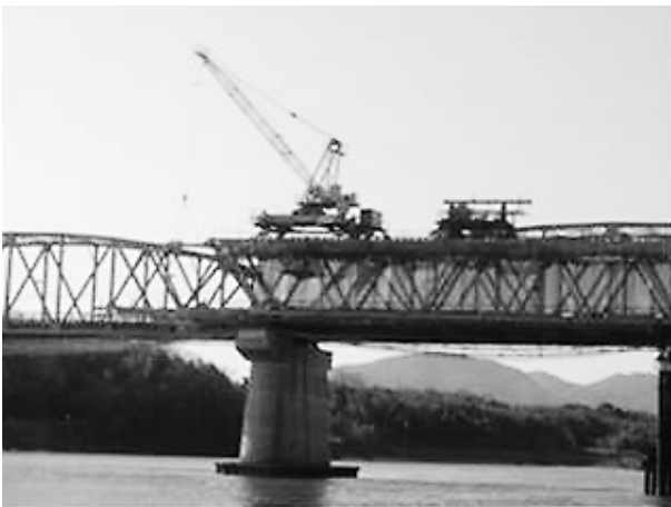
写真-5 P9-P10間のトラベラクレーン架設
