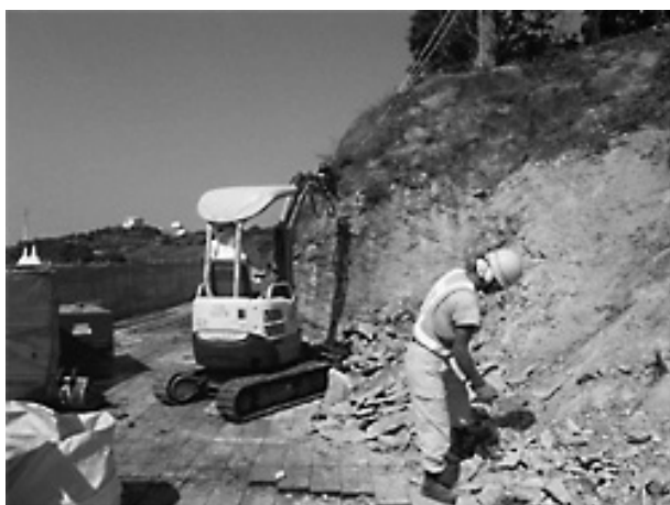
写真-6 既設吹付モルタル取壊状況
