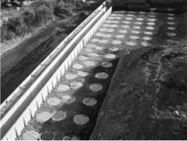
写真-4 深層改良完了
