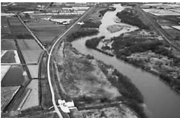
写真-1 工事箇所全景
