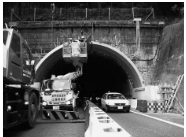
写真-4 プレキャストアーチ部材架設状況
