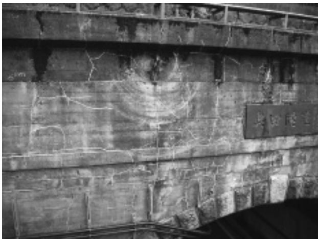
写真-2 坑口部構造物（面壁）の変状
