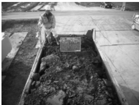
写真-7 ダンプ検収
