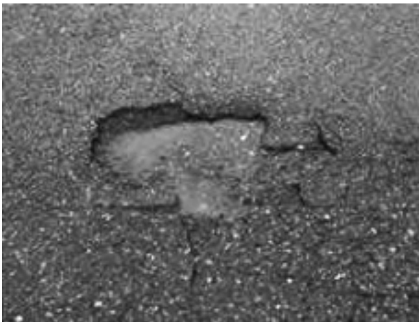
写真-1 施工前 (パンフレットより)
