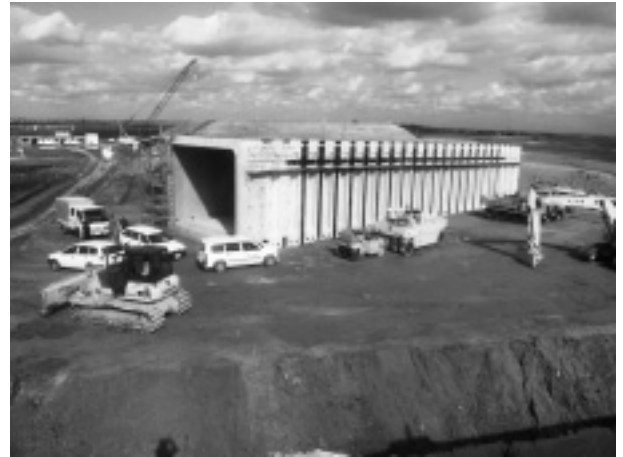
写真-3 据付完了状況
