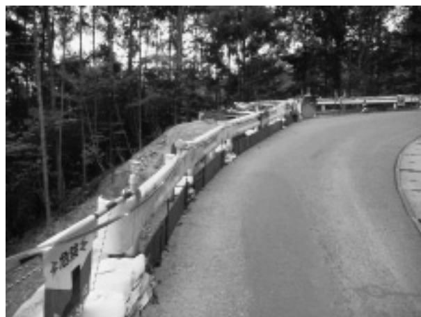
写真-1 ソーラー式ピカピカチューブ設置状況
