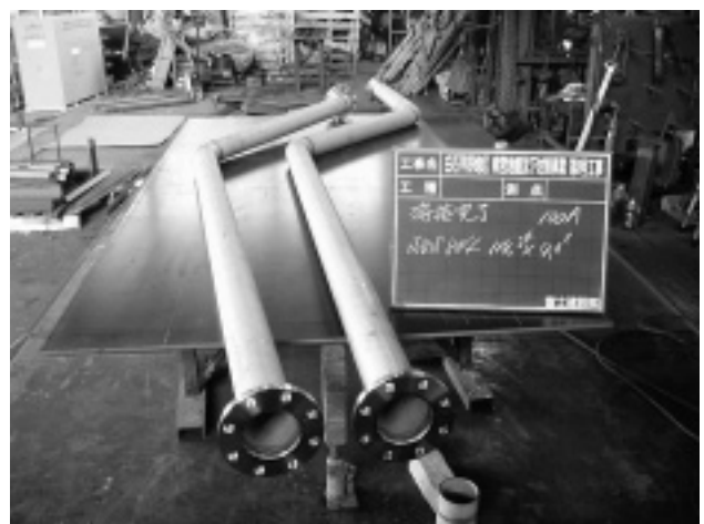
写真-1 ステンレス管溶接完了
