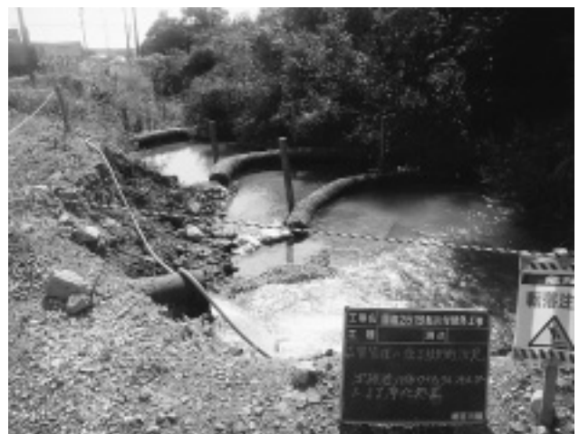
写真-3 ろ過設備
