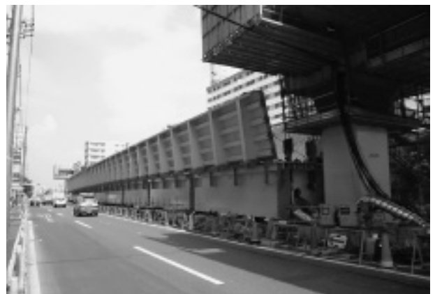
写真-2 鋼桁組立状況(昼間)
