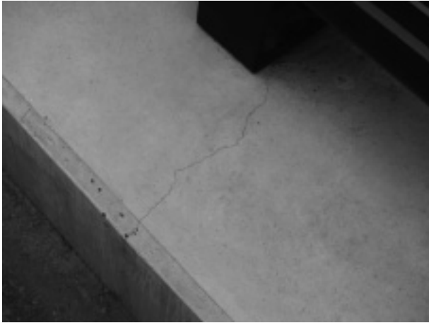
写真-1 他橋梁地覆打替
