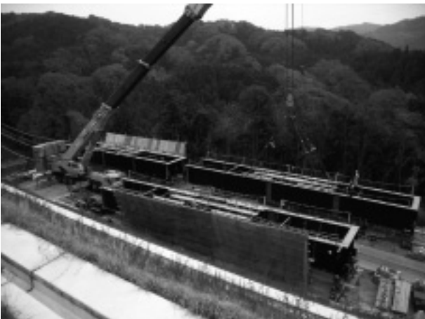
写真-1 桁地組状況
