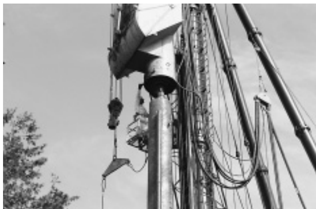
写真-1 中掘り機と相番クレー補助吊り
