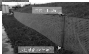
写真-2 ネット下端・芝状況
