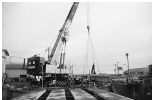
写真-2 160 t吊クレーンによる撤去作業状況写真
