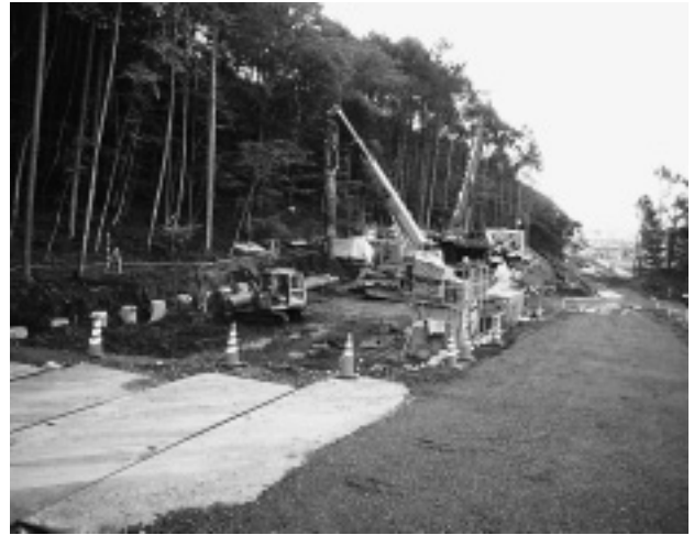
写真-3 杭打ち機と相番クレーン平行作業
