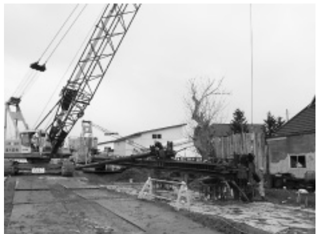
写真-2 杭打ち作業
