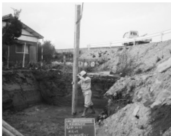
写真-3 基礎杭流用打込み状況
