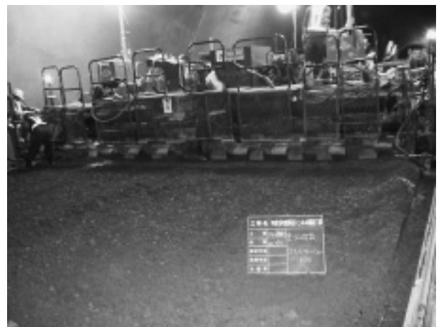
写真-5 二車線同時施工状況
