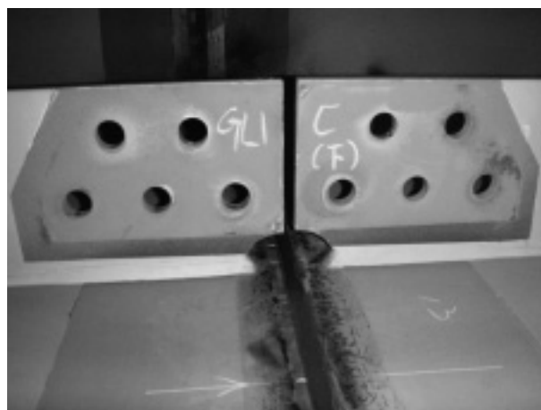
写真-3 溶接完了後摩擦接合面
