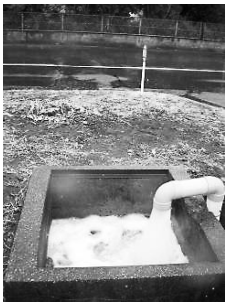
写真-3 フローターポンプによる強制排水状況
