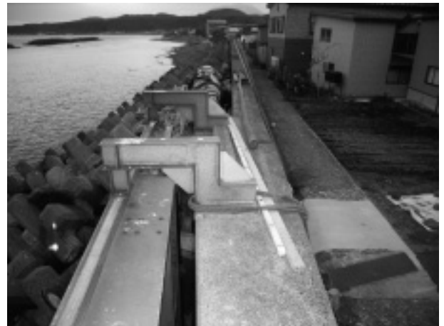
写真-1 既設護岸部
