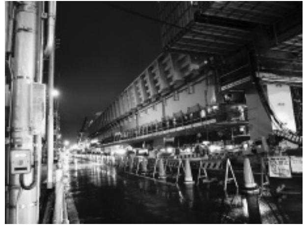
写真-4 交差点付近鋼桁一括吊上げ状況
