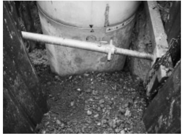
写真-2 基礎材一体化施工後
