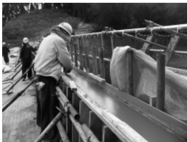
写真-5 仕上げ状況
