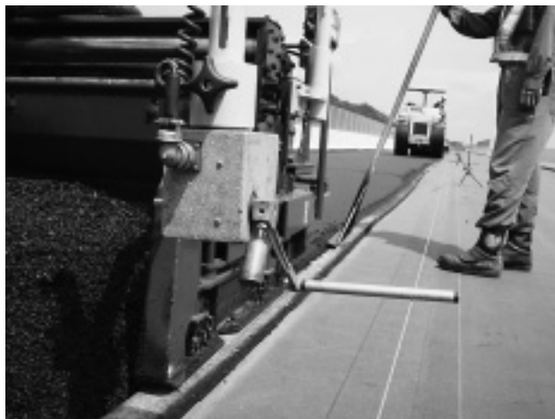
写真-3 センサーロープ設置
