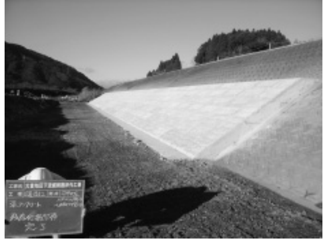
写真-5 完了写真（起点側より）
