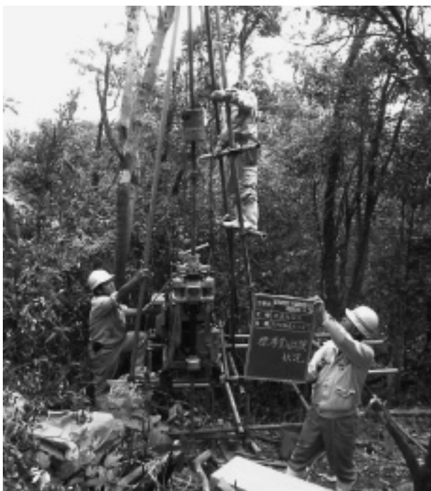
写真-2 現況地盤からの調査ボーリング
