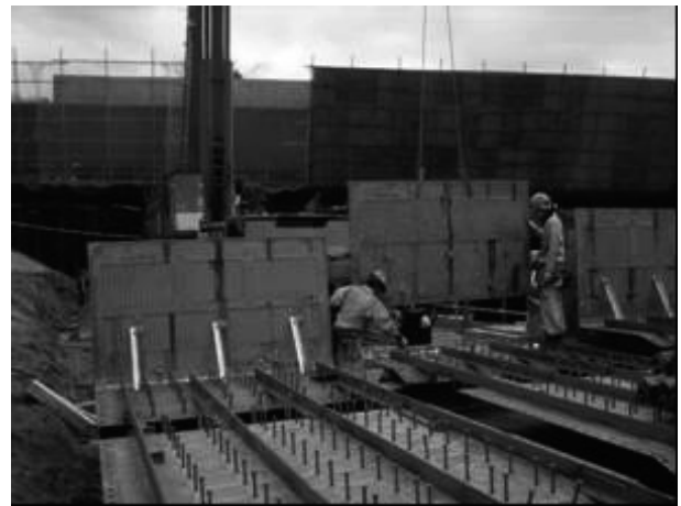
写真-2 合成床版と側面板(PCF)地組
