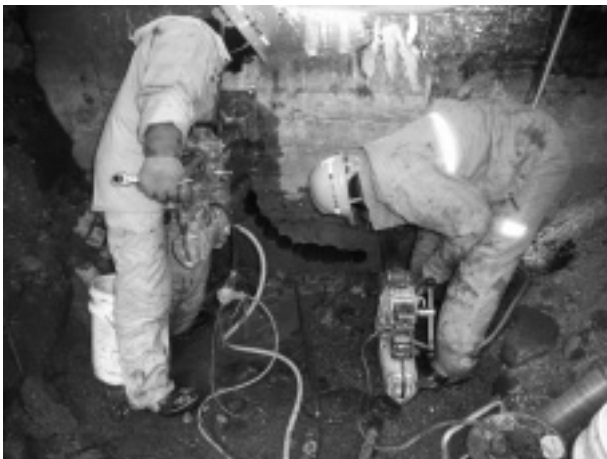
写真-3 コアカッター作業
