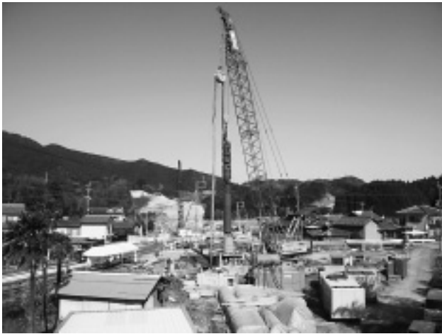
写真-1 マルチドライバー施工全景
