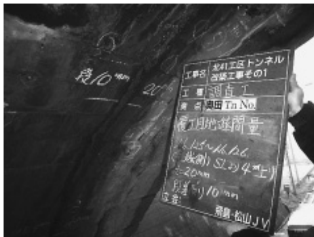
写真-3 目地の変状（目開き20mm、段差10mm）
