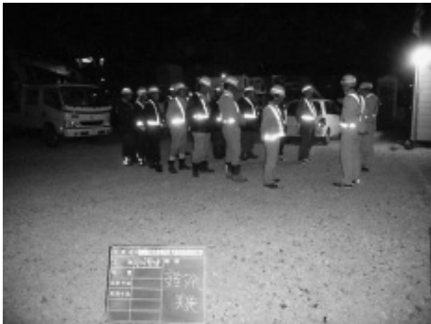
写真-2 作業前打ち合わせ
