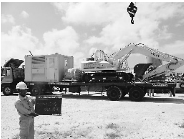
写真-1 水中バックホウ搬入状況
