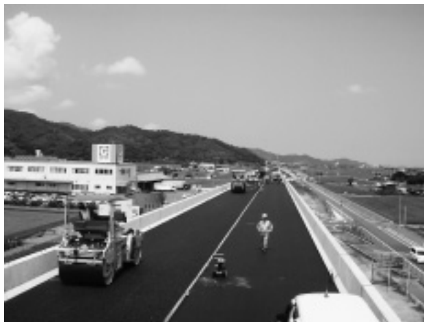
写真-4 表層施工状況
