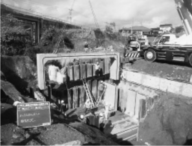
写真-8 ボックス据付状況
