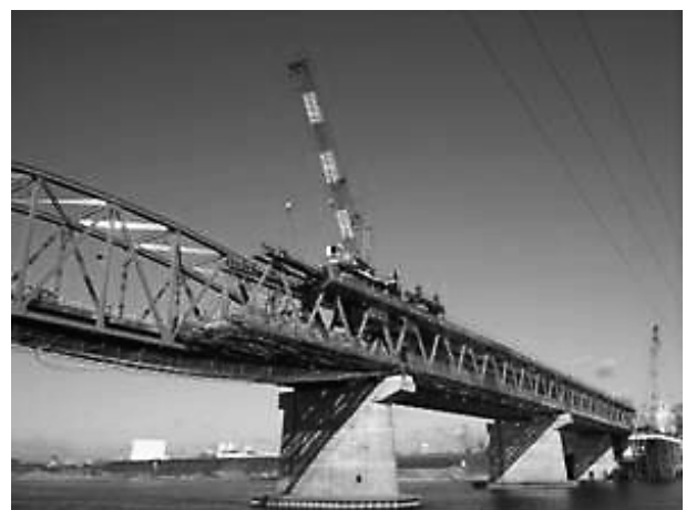
写真-2 トラベラクレーン架設
