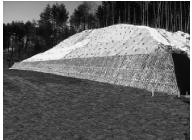
写真-2 鋼製組立枠
