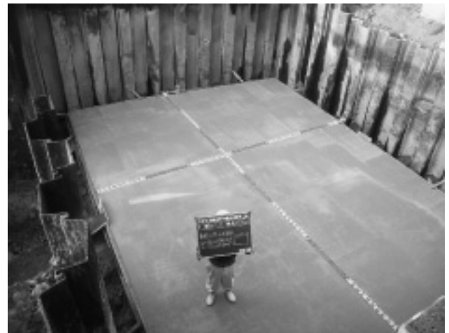
写真-7 仮締切完了
