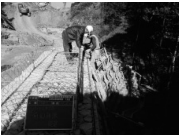
写真-2 前面補強（下部）
