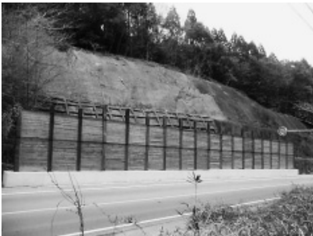
写真-1 現場状況
