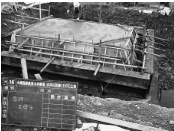
写真-1 型枠組立完了
