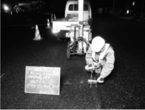
写真-4 転圧温度（初期）状況
