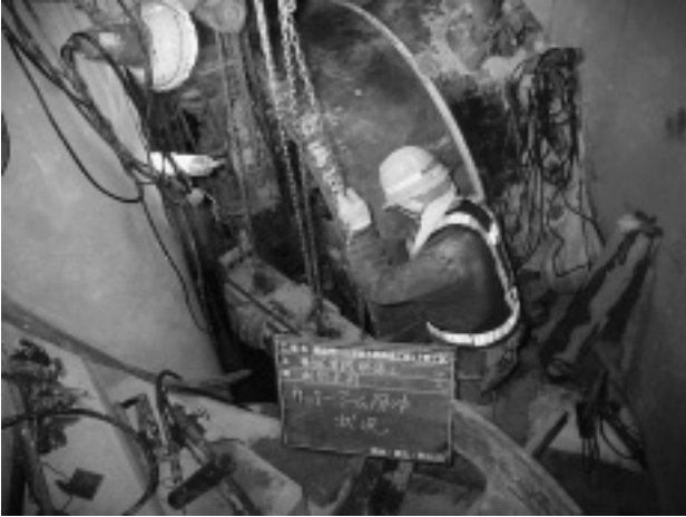
写真-4 掘進機解体状況
