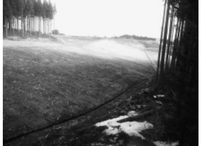
写真-6 盛土部完成
