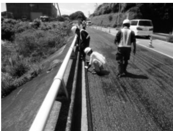
写真-2 導水管設置状況
