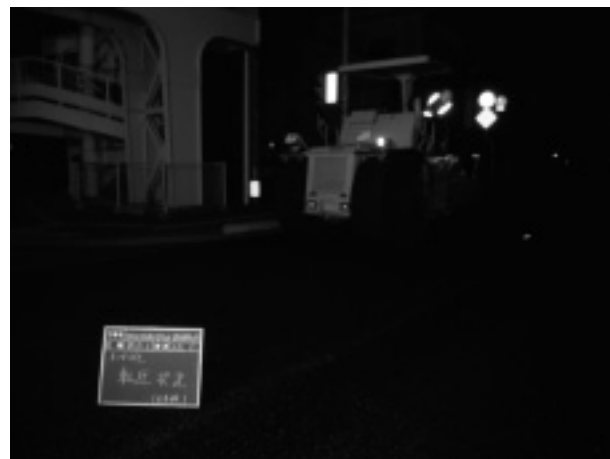
写真-2 二次転圧状況（マカダムローラー）
