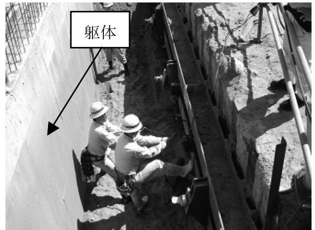
写真-3 人力による引抜き状況
