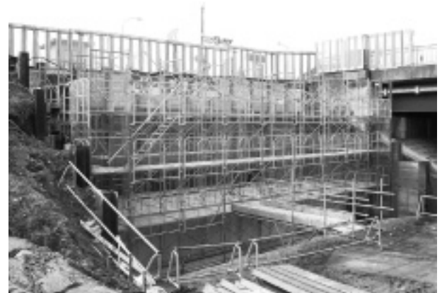
写真-3 足場設置完了時
