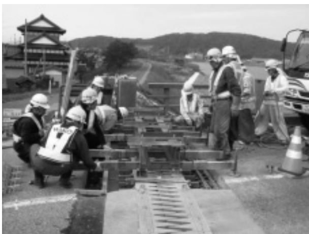
写真-2 鋼製伸縮継手仮固定状況
