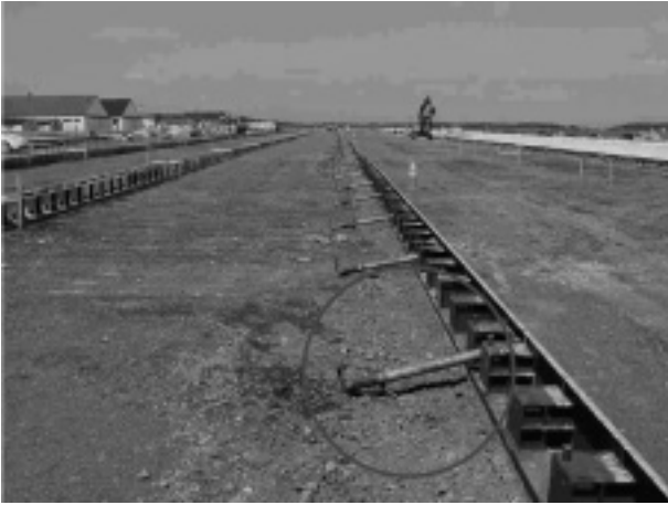
写真-1 通常は丸部の施工はしない。
