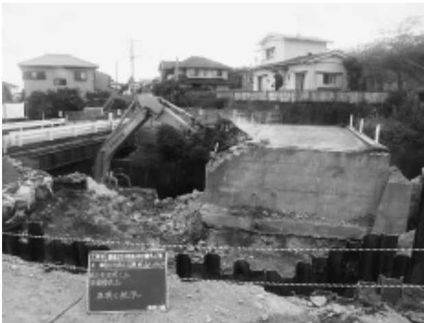
写真-6 大型ブレーカから油圧クラッシャーへ変更
