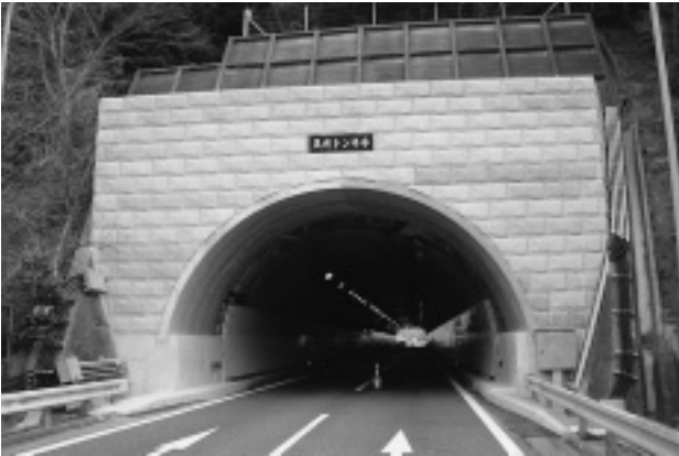
写真-5 トンネル坑口安定対策（完成）
