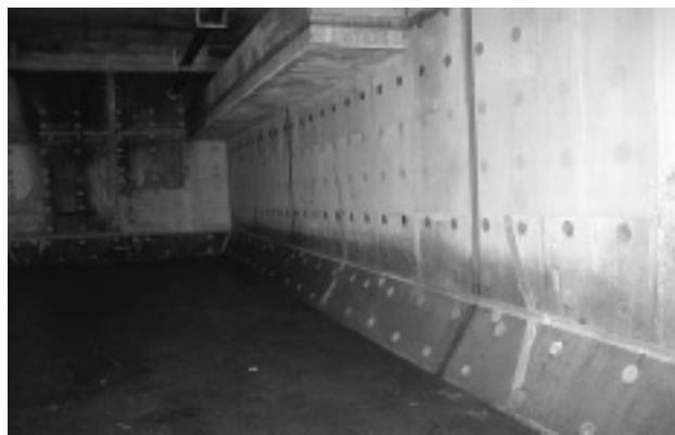
写真-2 【最初沈殿池ひび割れ発生位置 (D 壁)】
