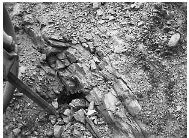
写真-2 表面部崩壊
