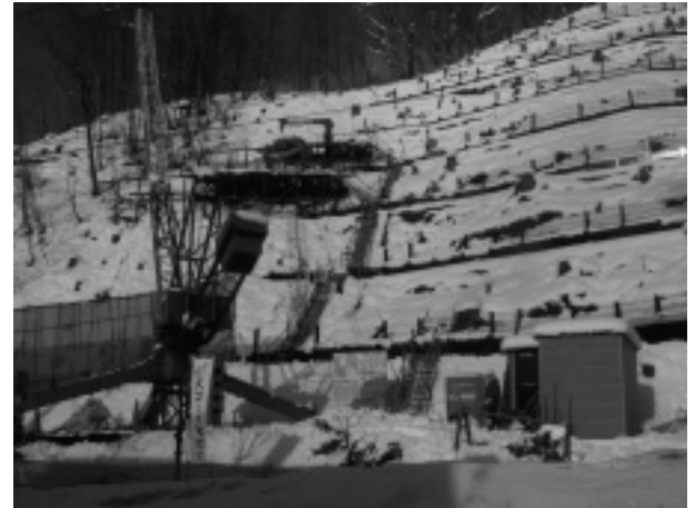
写真-2 施工現場
