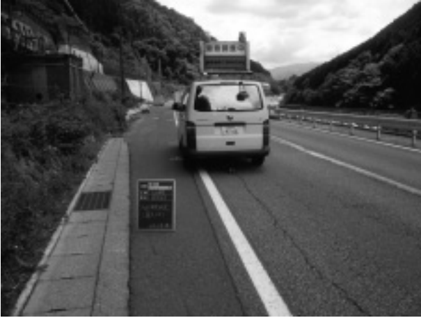
写真-5 FWD調査
