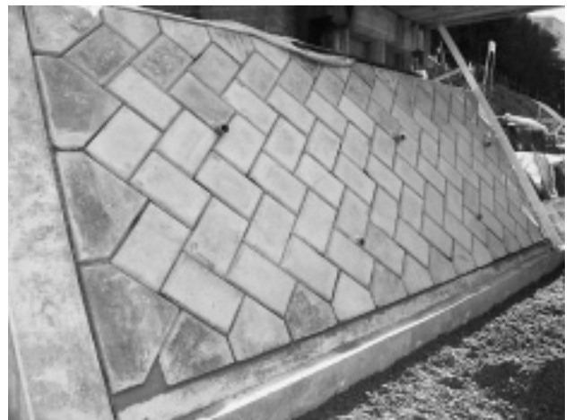
写真-3 ブロック据付完了
