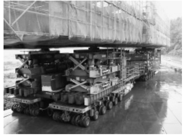
写真-2 多軸式移動台車とユニットジャッキ
