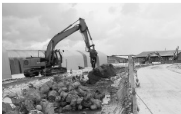
写真-3 既設用水路圧碎状況
