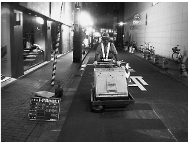
写真-2 余剰骨材回収状況
