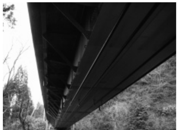
写真-2 完成 橋下面
