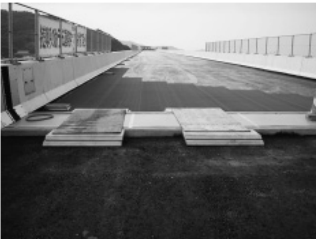
写真-6 専用ステップ設置
