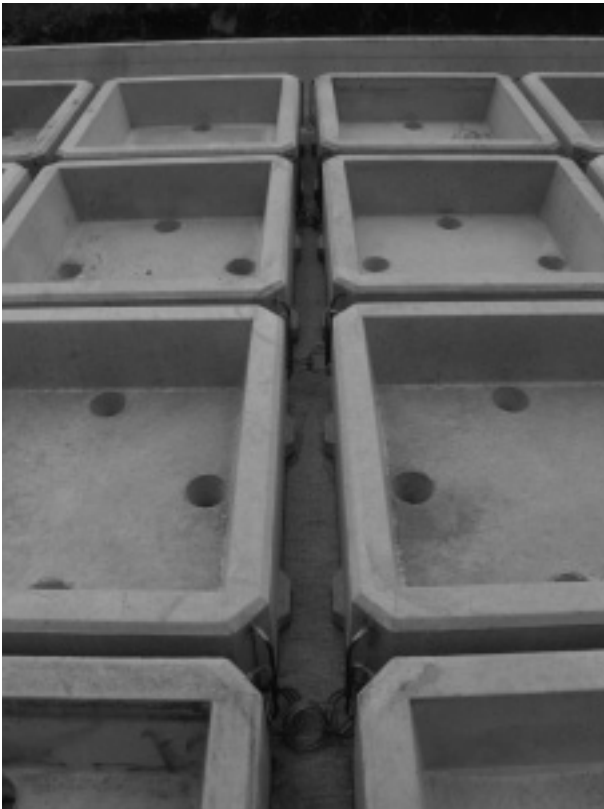
写真-2 据付完了
