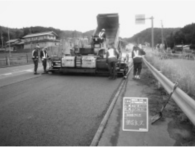
写真-4 舗装状況 (TV式アスファルトフィニッシャー)
