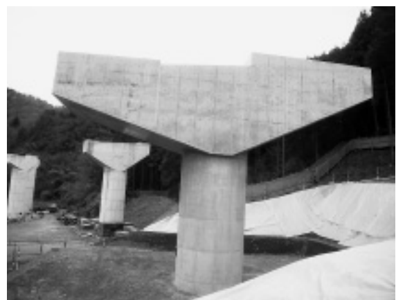
写真-5 完成 (BP4 橋脚)
