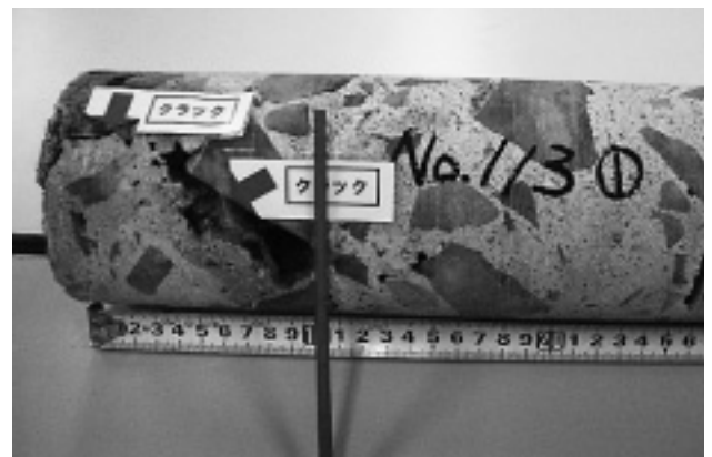
写真-1 コアボーリング試料
