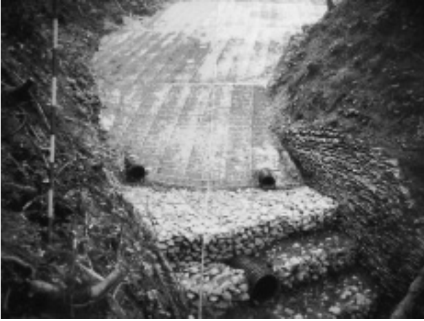
図-5 法面部完成
