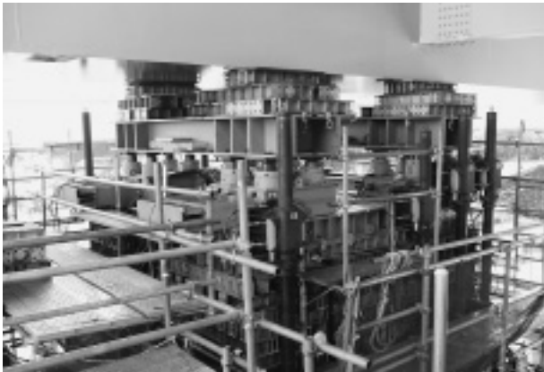
写真-1 スライドジャッキ使用状況
