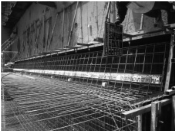
写真-2 スペーサー付鉄筋配置
