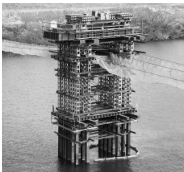
写真-4 中間ベント設備
