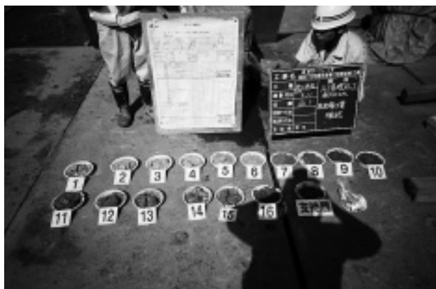
写真-1 土質確認状況
