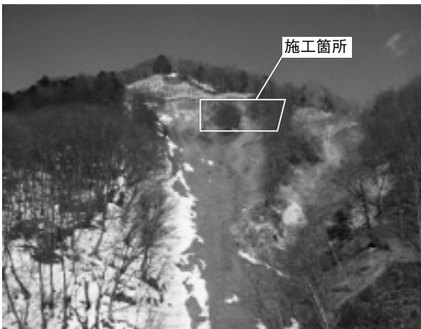
写真-1 施工前全景（3月）
