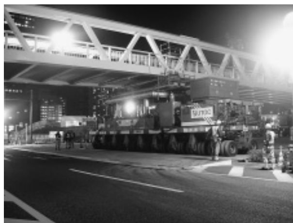
写真-4 多軸式特殊台車（9軸）
