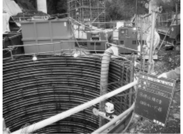
写真-3 レーザービーム設置
