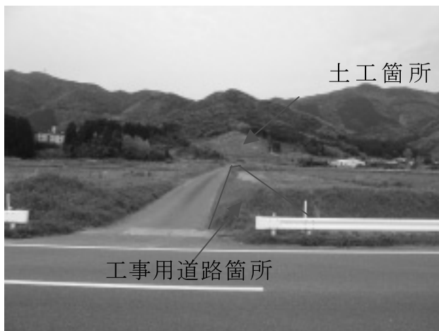
写真-1 施工箇所
