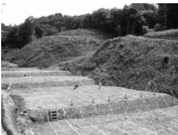
写真-2 施工基面整形後
