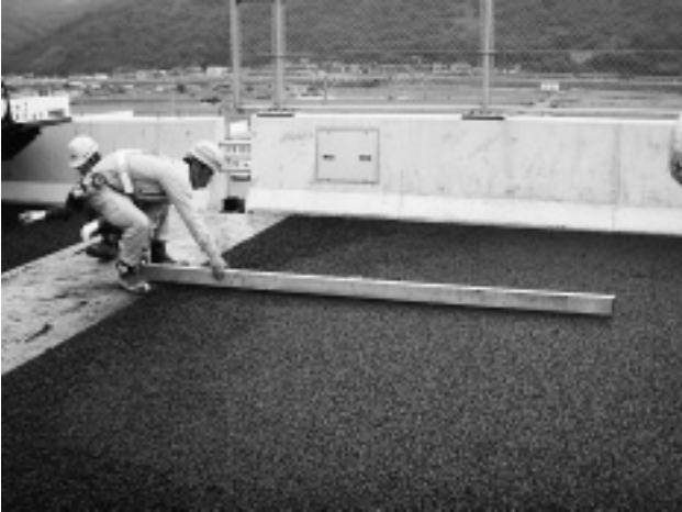
写真-5 3 m定規使用状況
