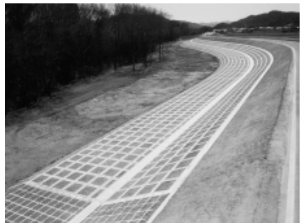
写真-4 護岸ブロック全景
