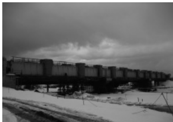
写真-3 防寒養生
