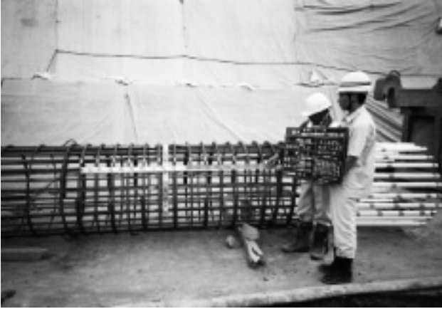
写真-5 施工検査状況
