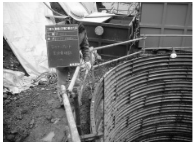
写真-1 反射シート設置
