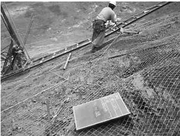
写真-3 クライマードリル移動状況
