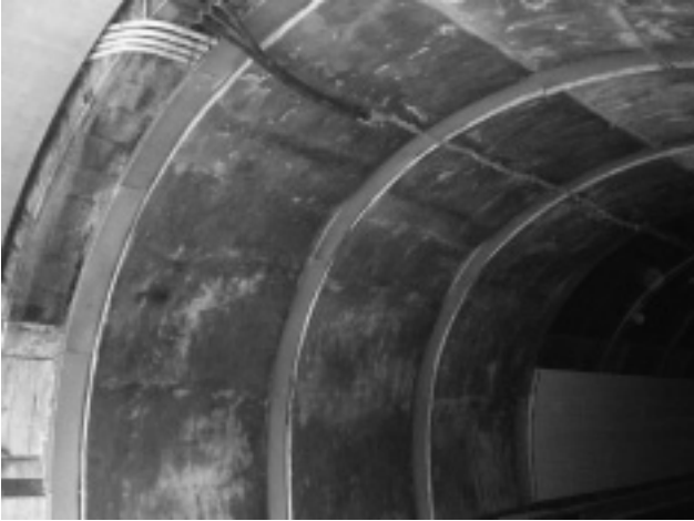
写真-7 覆工コンクリート補強 (完成)
