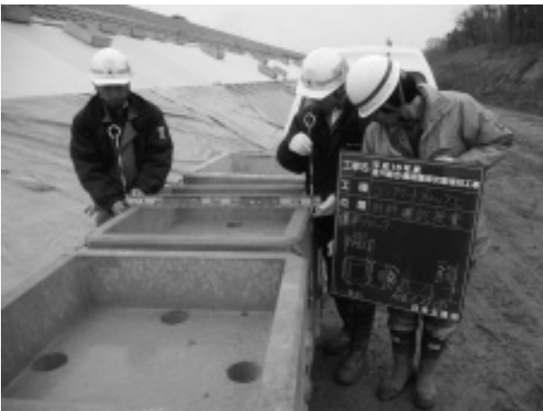
写真-1 護岸ブロック
