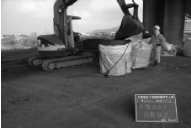
写真-3 土砂投入
