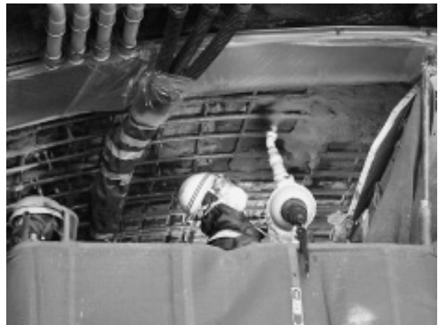
写真-6 TDR ショット吹付け作業
