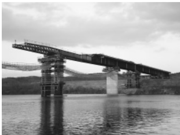
写真-5 桁送出し状況
