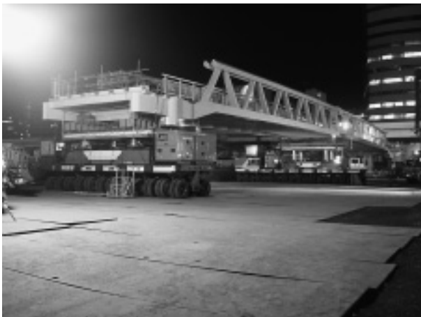
写真-6 台車搭載状況
