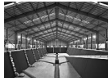
c) 最終処分場内部
