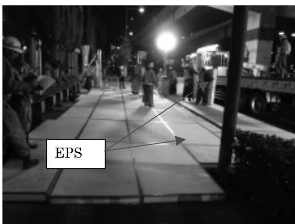
写真-2 EPS 設置
