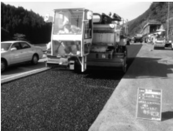
写真-2 プレコート骨材散布状況
