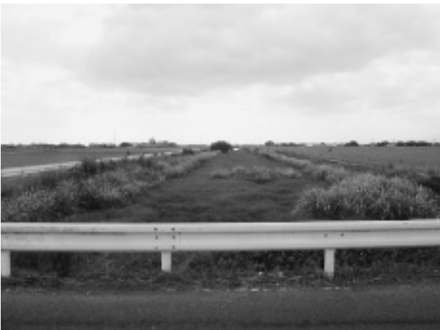
写真-1 18-1号 着工前
