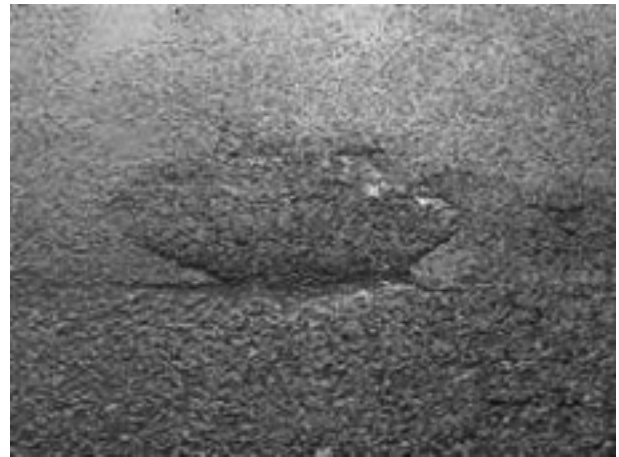
写真-2 施工後 (パンフレットより)
