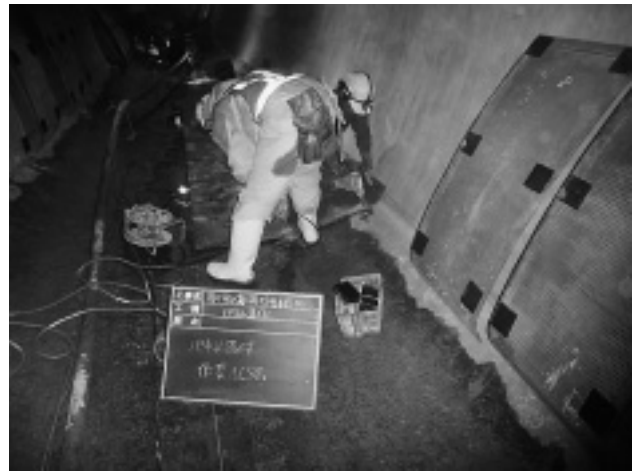
写真-7 ダグタルパネル設置状況
