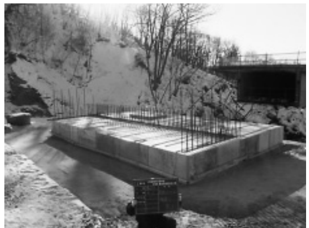
写真-3 断熱材養生実施状況
