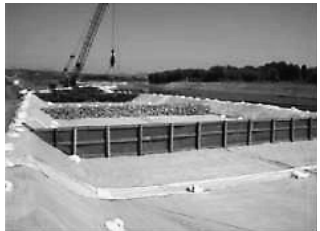
写真-6 ろ過池全景
