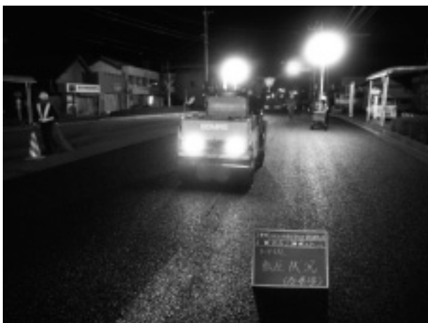
写真-1 初期転圧状況（コンバインドローラー）
