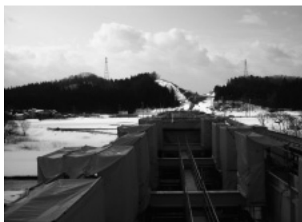
写真-4 防寒養生
