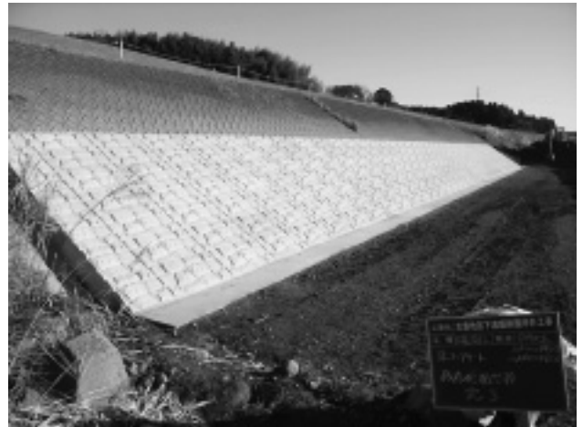
写真-6 完了写真（終点側より）
