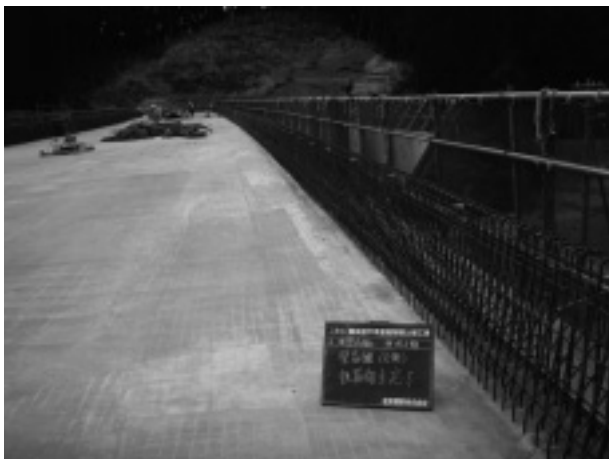
写真-2 鉄筋組立完了
