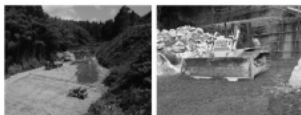
写真-4、5 盛り土場内盛土状況
