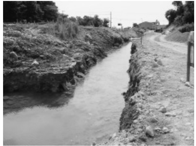
写真-1 掘削時湧水
