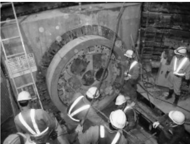
写真-5 駆動部引揚げ状況
