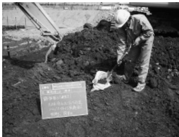
写真-4 掘削土自然乾燥試料採取
