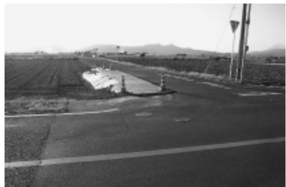
写真-5 農道進入口拡幅
