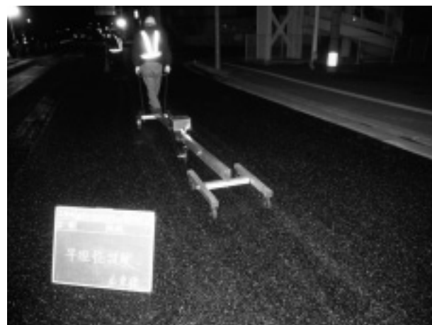
写真-3 平坦性試験状況
