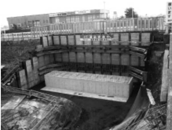
写真-2 躯体1ロット完了時の土留状況
