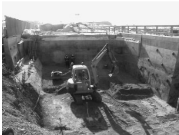
写真-3 軽量盛土施工
