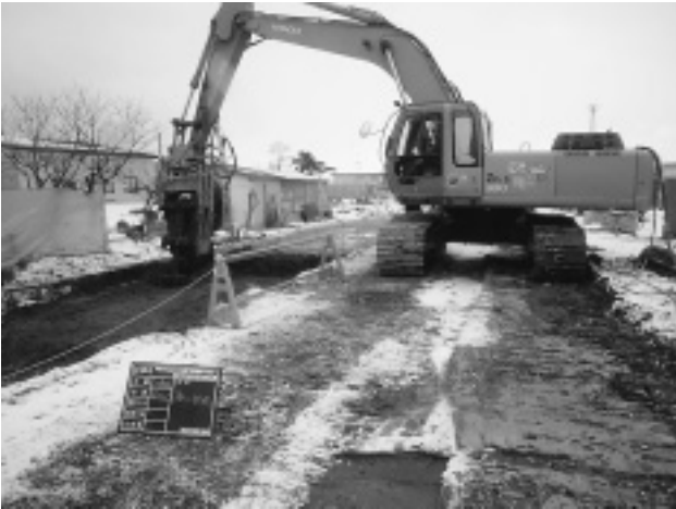
写真-3 地盤改良攪拌作業
