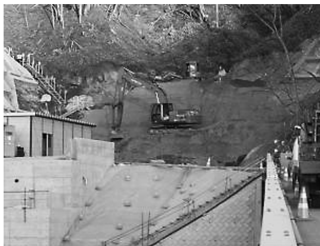
写真-2 坑口補強盛土施工状況
