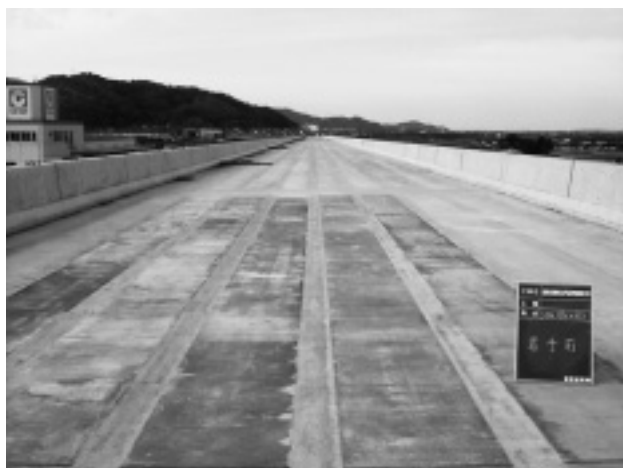
写真-2 橋梁部着手前
