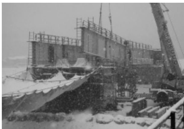
写真-1 桁架設状況
