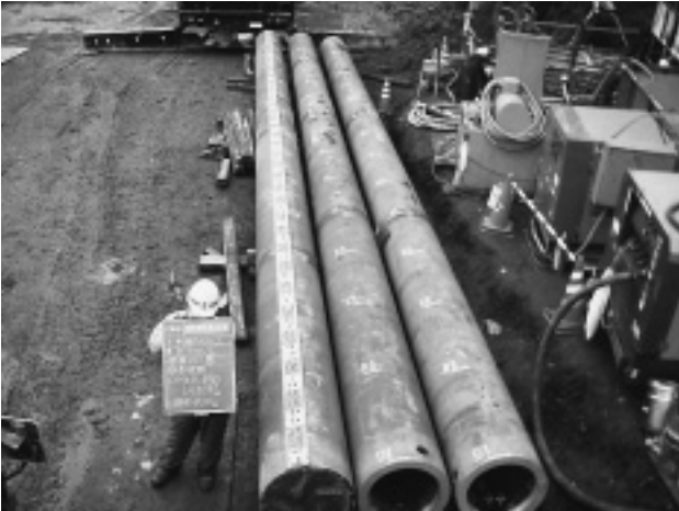
写真-1 鋼管杭 L=15.0m (溶接製品)
