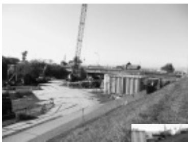
写真-1 仮囲い設置状況
