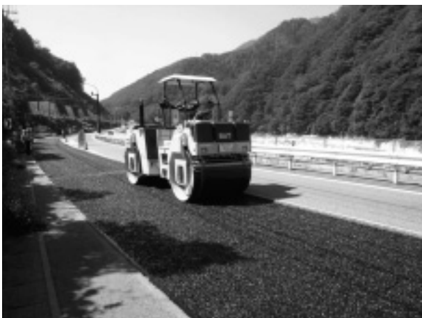
写真-3 転圧状況
