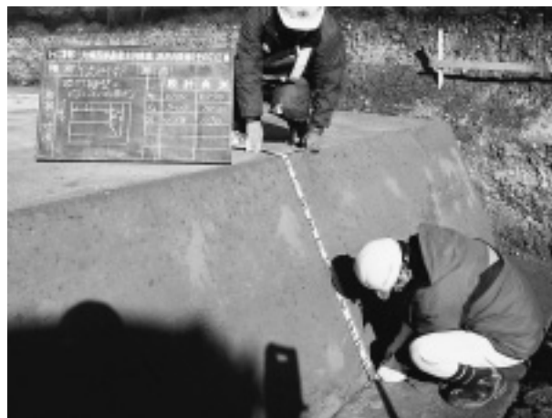
写真-2 均しコンクリート完了
