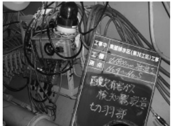
写真-8 定置式ガス測定器 (切羽側)
