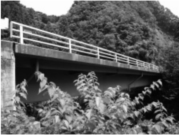
写真-3 着工前 橋側面
