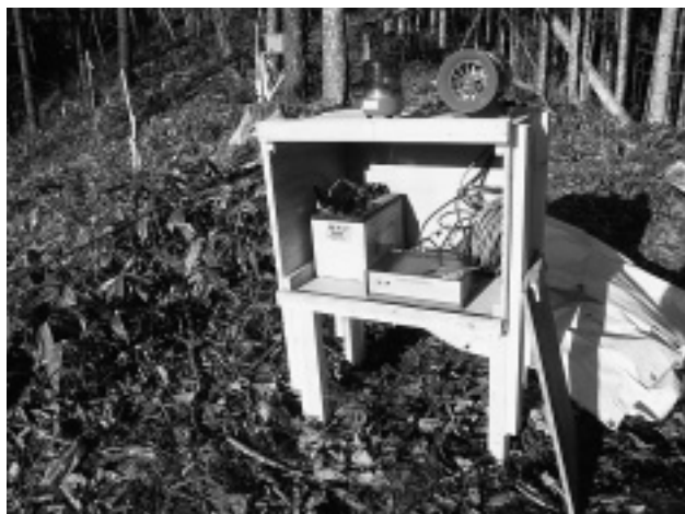
写真-4 地すべり警報装置
