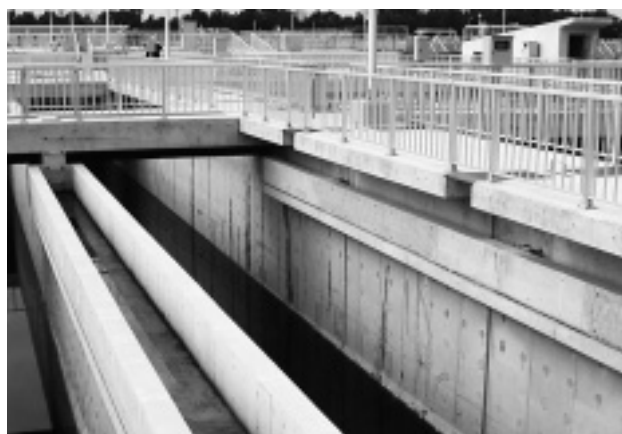
写真-4 【最終沈殿池ひび割れ発生位置 (D 壁)】
