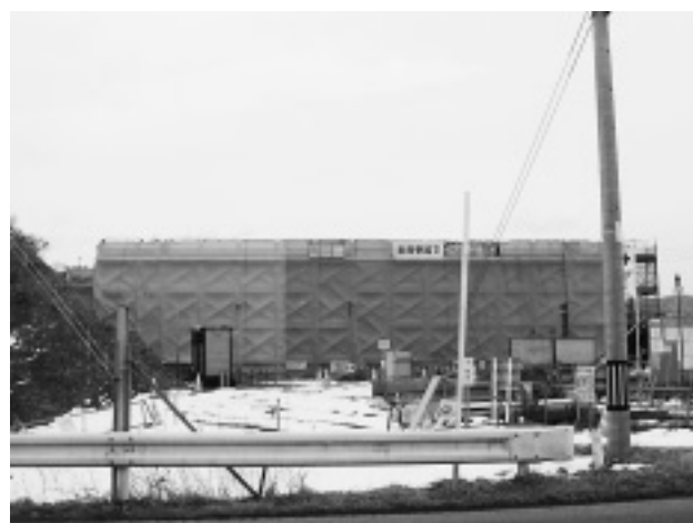
写真-3 シート養生全景
