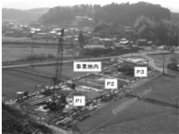
写真-1 現場全景
