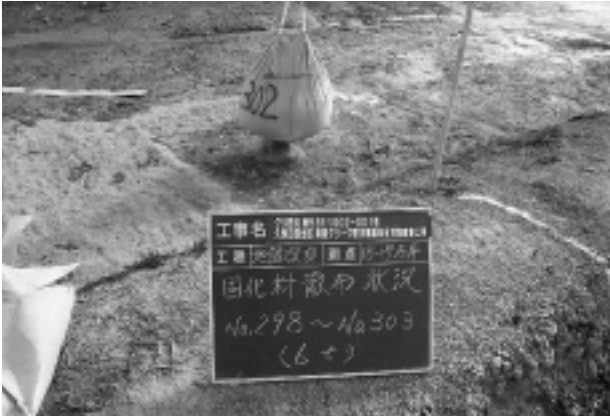
写真-9 固材散布状況
