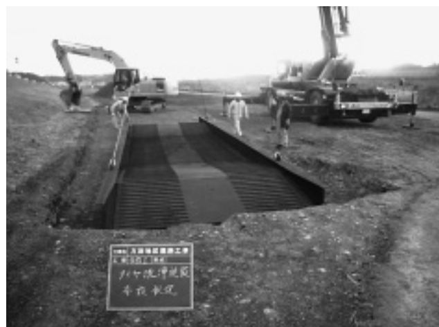
写真-2 現場内への設置状況
