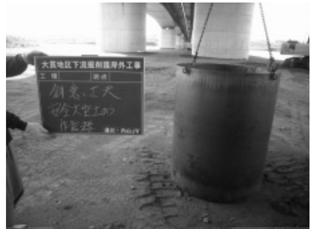
写真-1 大型土のう製作器
