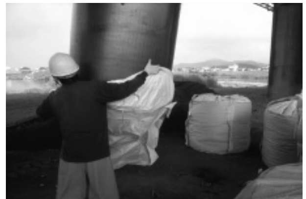
写真-2 土嚢袋のはめ込み
