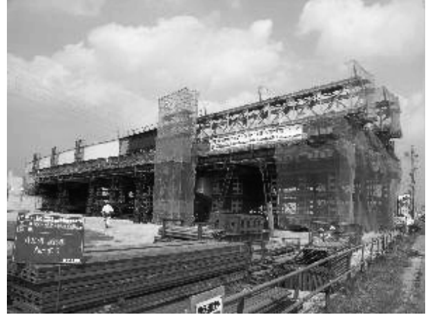
写真-2 送出し前の地組立
