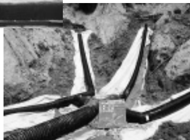
有孔管による 地下排水工
