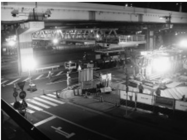
写真-7 一括架設状況
