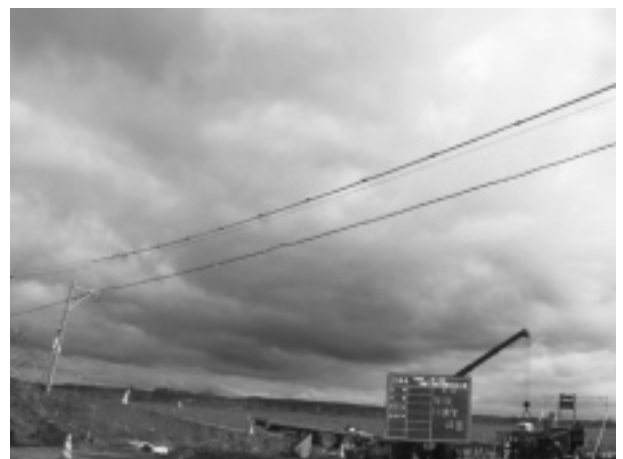
写真-1 防護管取付け完了
