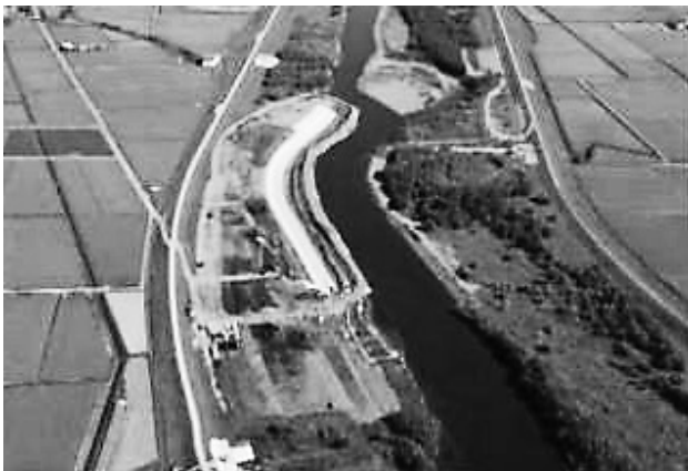
写真-2 右岸仮締切り施工状況
