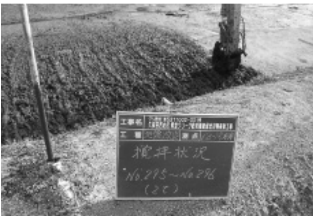
写真-10 攪拌状況
