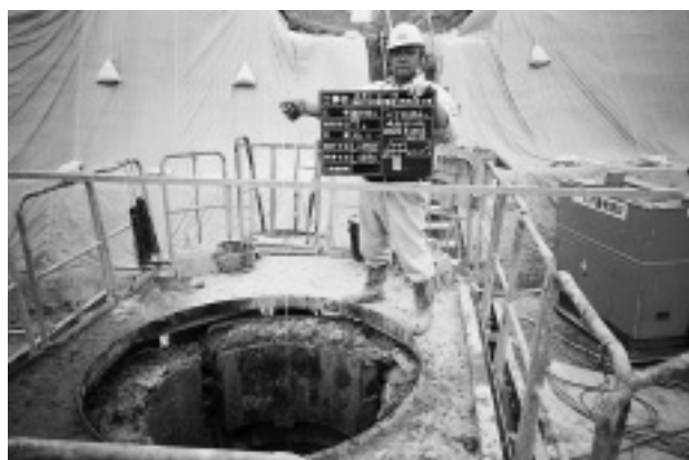
写真-3 鉄筋かご高測定状況
