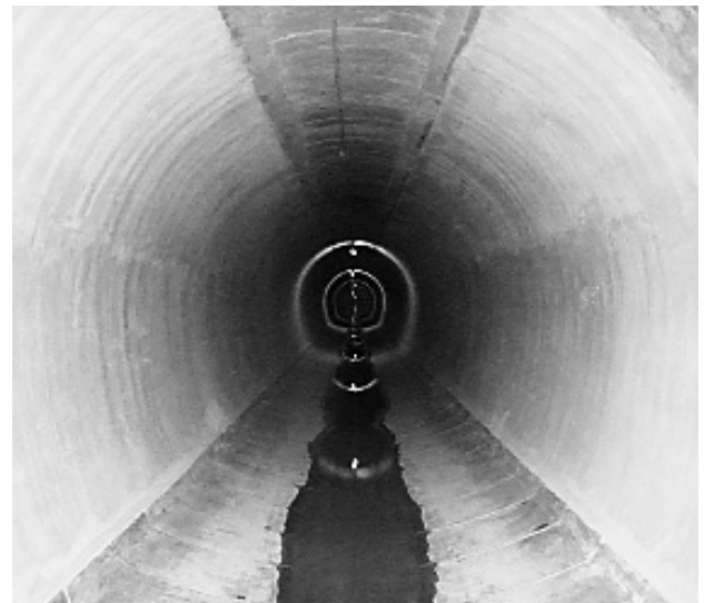
写真-1 標準部完成状況
