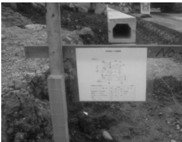
写真-8 左（丁張に詳細図掲示）
