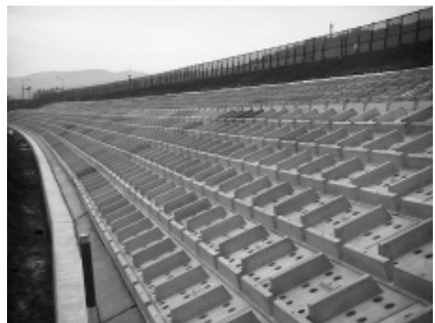
写真-1 大型連節ブロック完了
