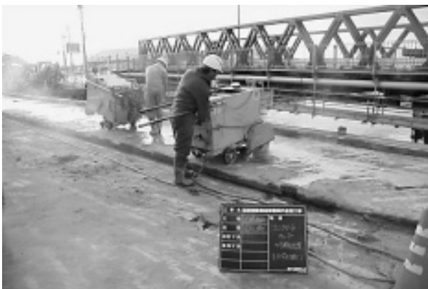
写真-1 コンクリートカッターによる切断作業状況写真
