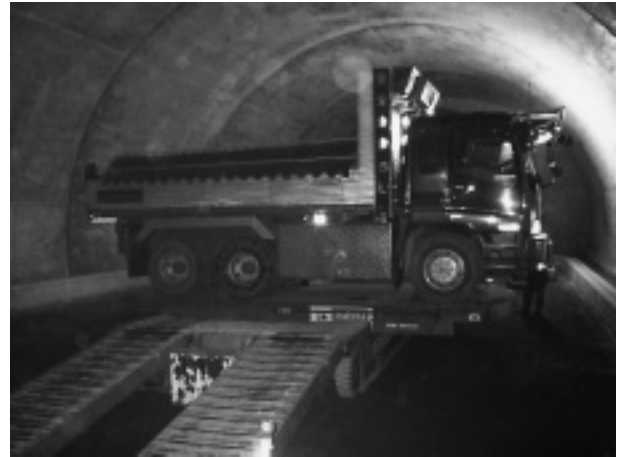
写真-4 移動式ターンテーブルによる方向転換状況
