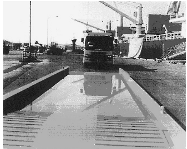
写真-1 簡易設置型タイヤ洗浄施設
