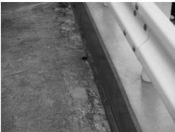
写真-5 施工後（排水溝）
