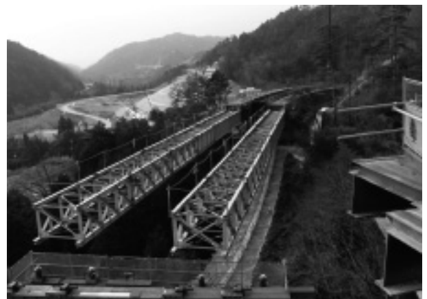
写真-2 桁張出し状況
