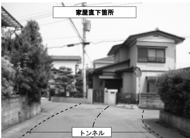
写真-1 家屋直下部（土被り約5m）の地表状況
