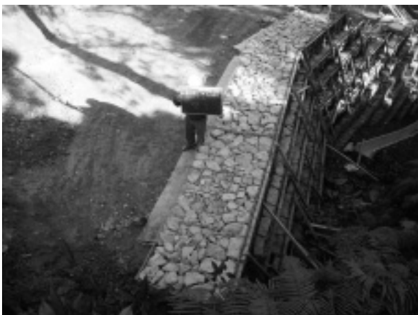
写真-3 前面補強（上部）
