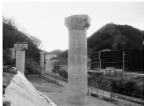
写真-4 完成 (D1P2 橋脚)
