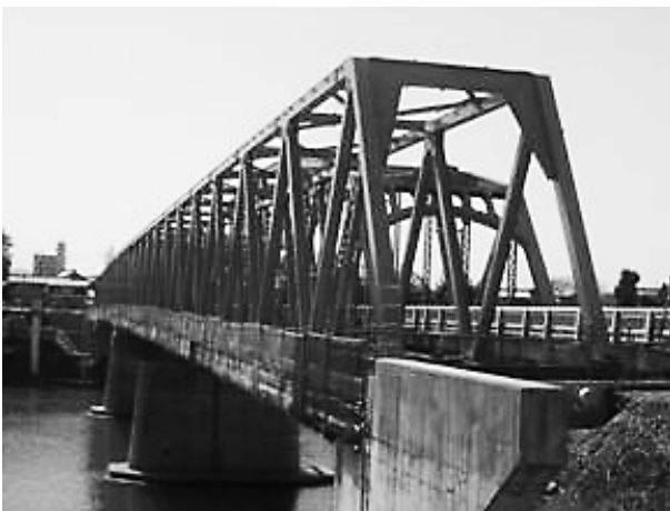
写真-1 太田橋側道橋
