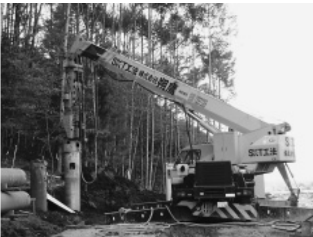
写真-2 杭打ち機削孔作業
