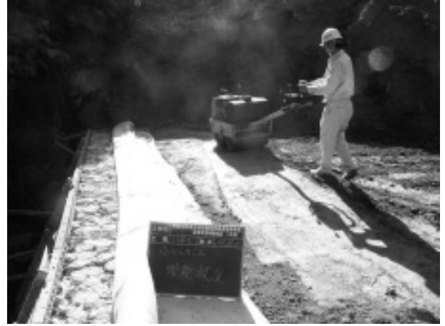
写真-6 背面締め固め状況
