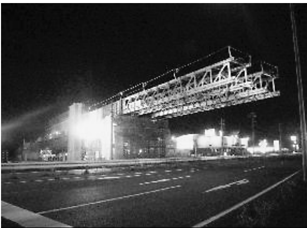
写真-3 送出し架設状況
