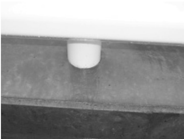
写真-2 当社施工地覆打替
