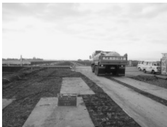
写真-8 固化材搬入状況
