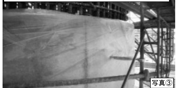
型枠解体後にポリフィルムシートでの被膜養生実施
