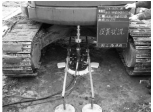
写真-1 平板載荷試験設置状況
