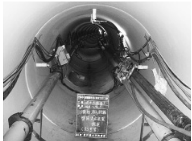
写真-1 滑材注入装置
