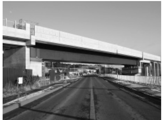
写真-4 完成写真
