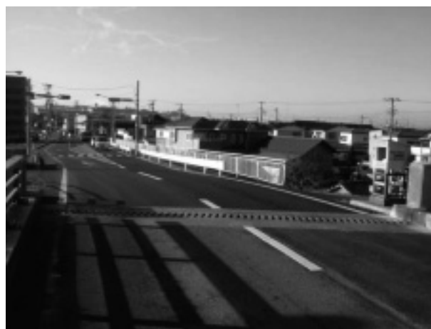
写真-3 工事完了後全景
