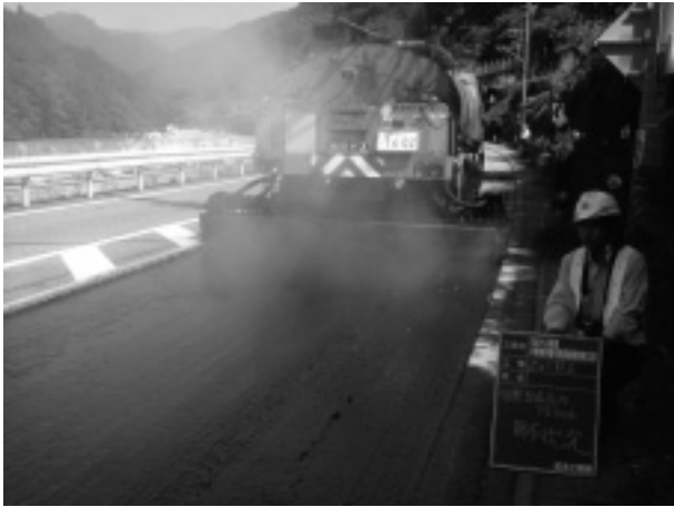
写真-1 加熱型高ゴム化As散布状況
