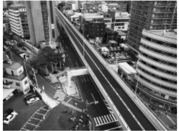
写真-6 新小岩陸橋完成
