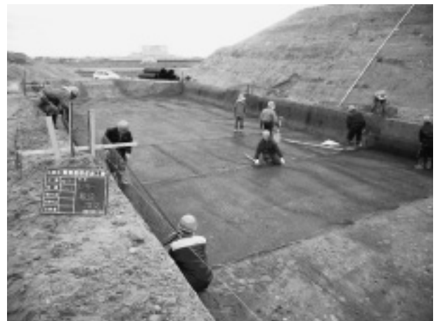
写真-1 テンサー敷設状況
