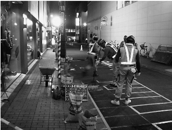
写真-1 バインダ樹脂塗布 及び 骨材散布
