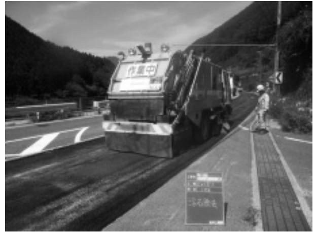
写真-4 浮石除去状況
