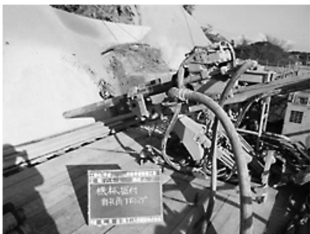
写真-7 グラウンドアンカー削孔状況
