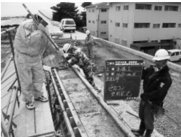
写真-2 ピカコン施工状況
