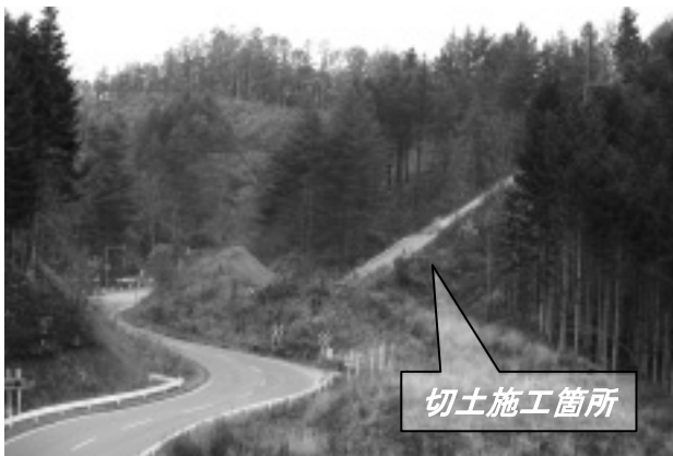
写真-1 切土施工箇所（工事着工前）
