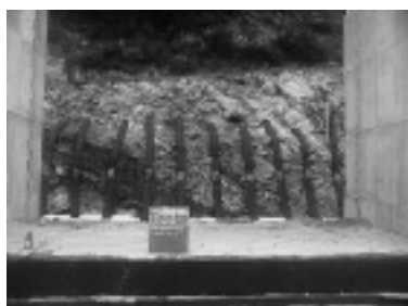
面状排水材による 法面排水
