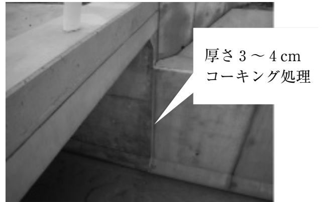
写真-3 構造物とL型のコーキング仕上げ
