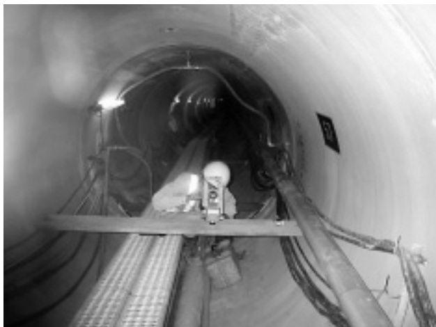
写真-2 測量状況
