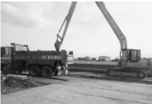
写真-11 残土積込状況
