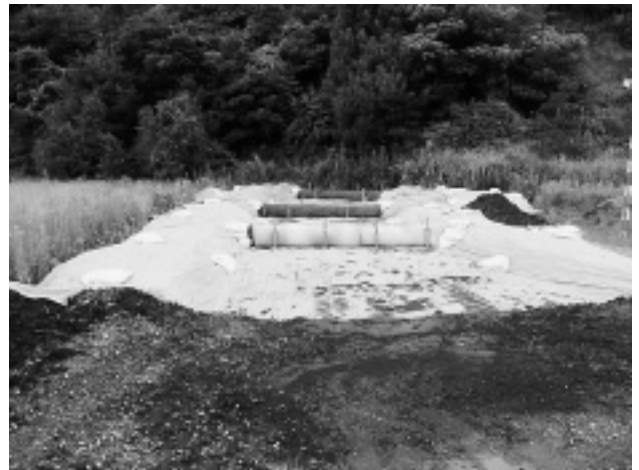
写真-3 濁水濾過池
