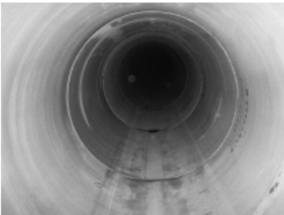
写真-10 施工完了
