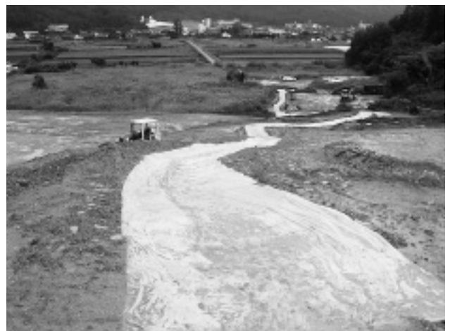
写真-4 降雨流下箇所ビニールシート敷設 (土工箇所)
