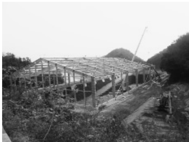
b) 鉄骨の組み上げ状況
