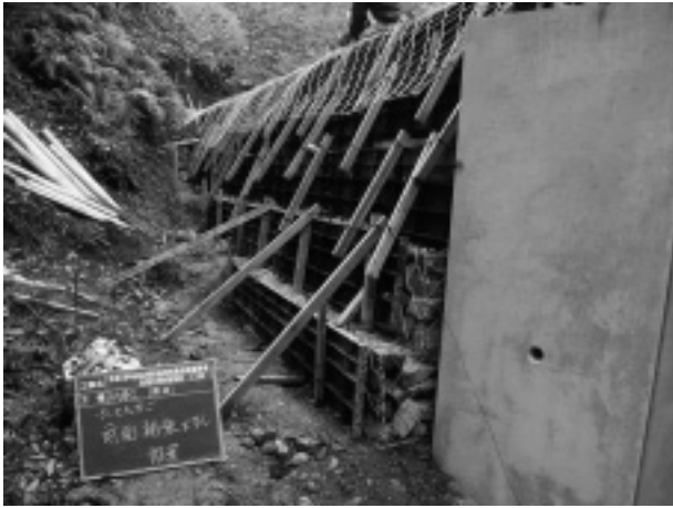
写真-1 前面補強（下部）
