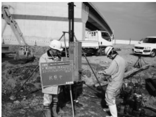
写真-2 オートマチックラムサウンディング試験
