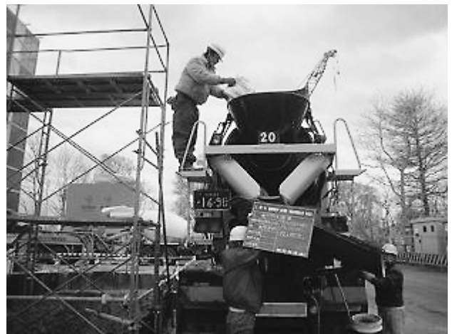
写真-3 クラック抑制ファイバー混入状況
