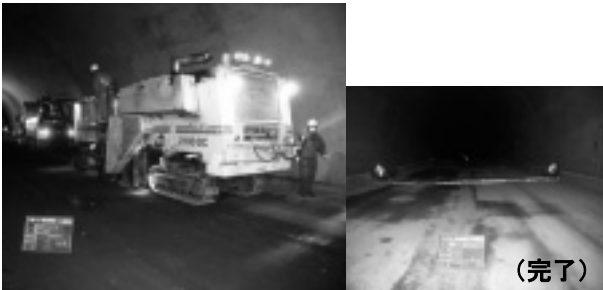
写真-2 切削機による路床成形
