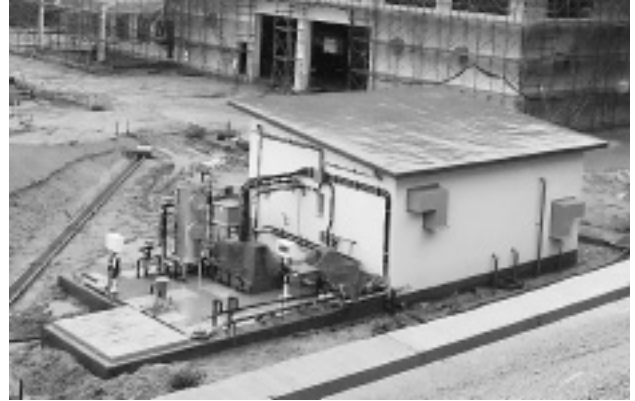
写真-5 浸出水処理施設
