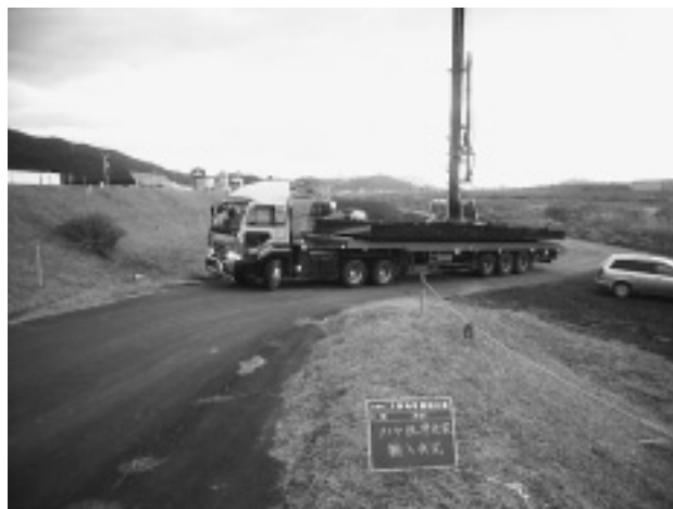
写真-3 大型トレーラーによる運搬
