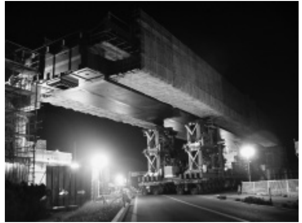
写真-3 一括架設状況
