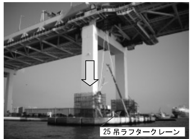
写真-7 ケーブル下端架設状況
