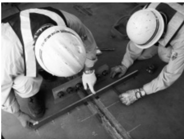
写真-2 角変形計測
