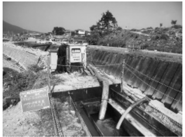
写真-2 沈殿槽・自動アルカリ中和装置
