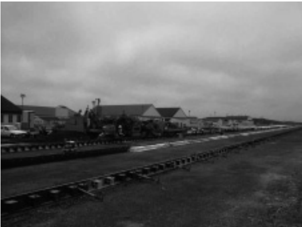
写真-2 施工状況
