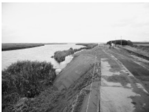
写真-2 堤防外盛土
