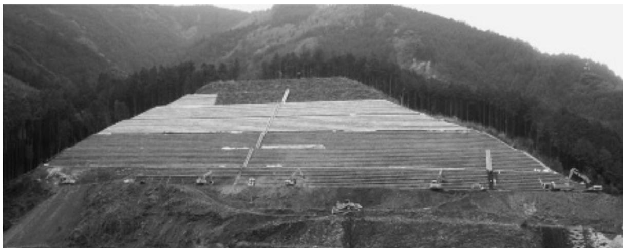
写真-3 法面工（ポット苗）全景
