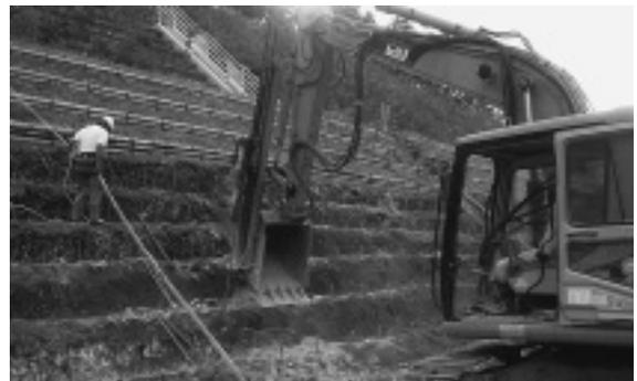
写真-1 法面の2段施工
