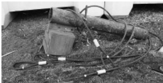
写真-1 吊金具構造詳細
