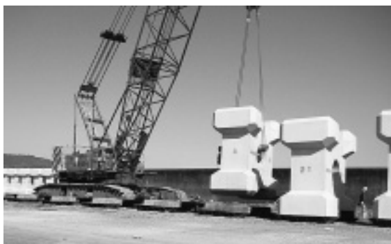
写真-2 吊上げ作業時状況
