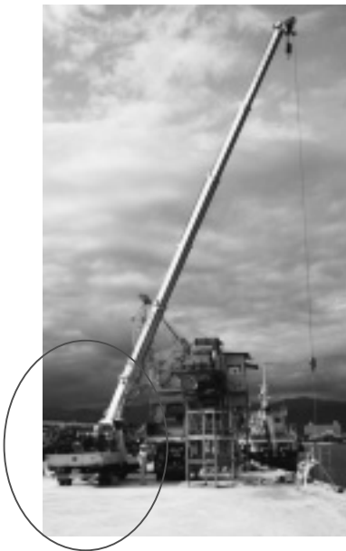
写真-2 足場クレーンによる転用状況
