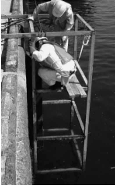
写真-1 作業足場詳細
