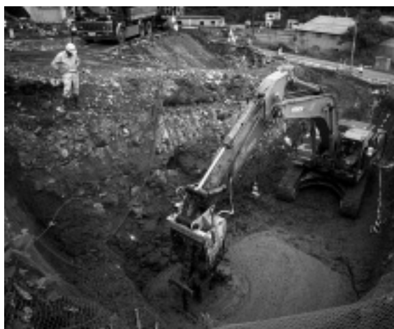
写真-4 セメント注入状況
