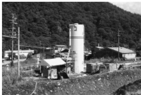
写真-2 プラント設置状況
