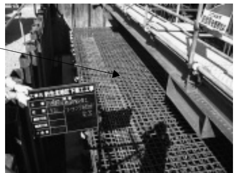
写真-3 改善鉄筋足場による鉄筋組立完了状況
