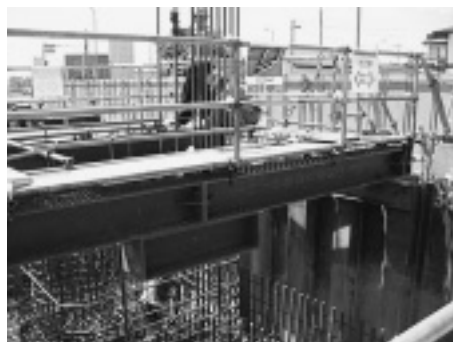
写真-2 改善鉄筋足場による鉄筋組立施工状況
