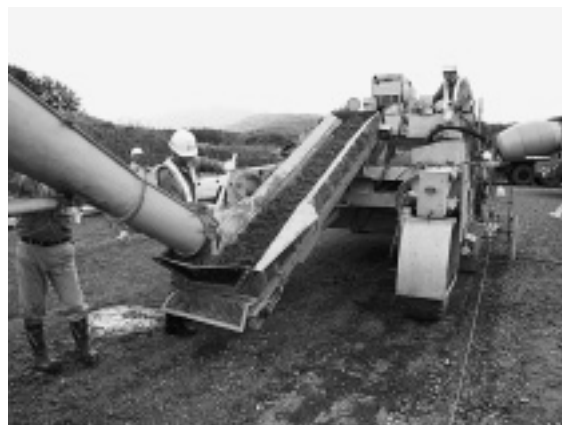
写真-1 コンクリート投入状況
