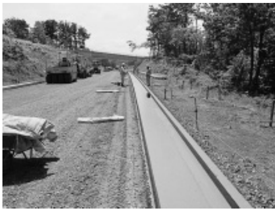
写真-3 コンクリート打設完了
