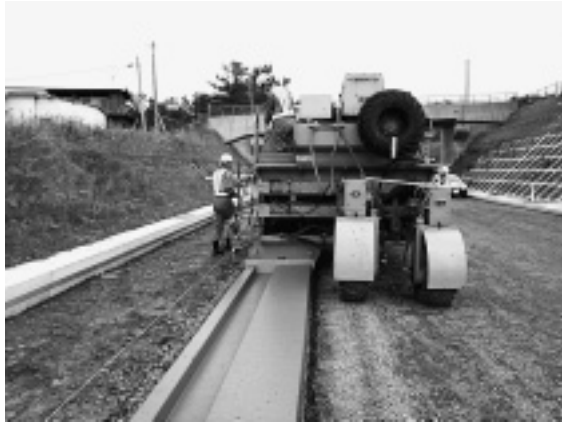
写真-2 コンクリート打設状況
