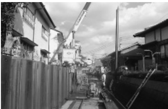
写真-2 変更後の搬送機施工中
