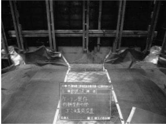
写真-1 柵型枠内部ゴミ収集袋設置
