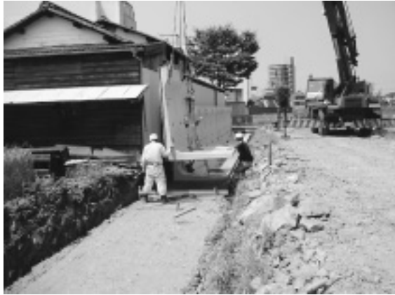
写真-1 プレキャスト製品の採用
