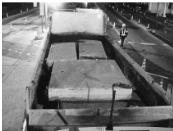
写真-3 積込状況
