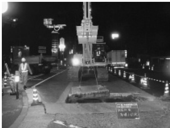
写真-2 舗装版撤去状況
