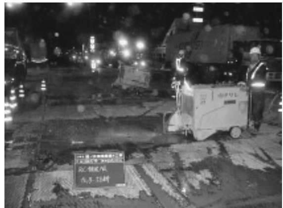
写真-1 舗装版切断状況
