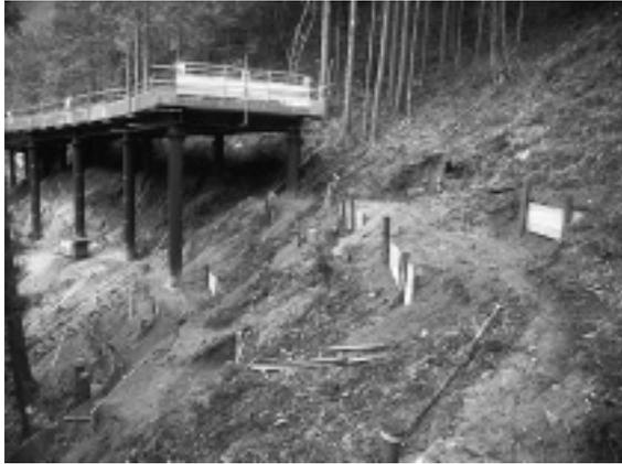
写真-2 土留柵・掘削土流出防護柵の設置
