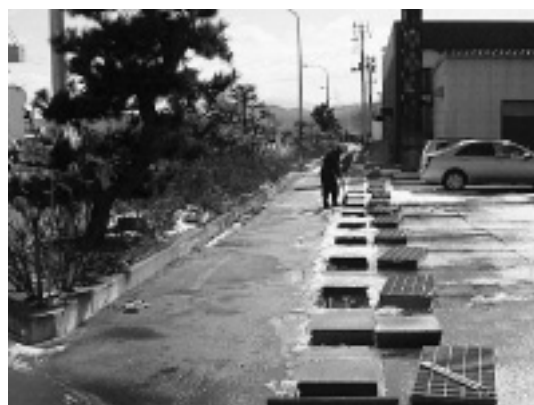
写真-2 排水溝清掃状況
