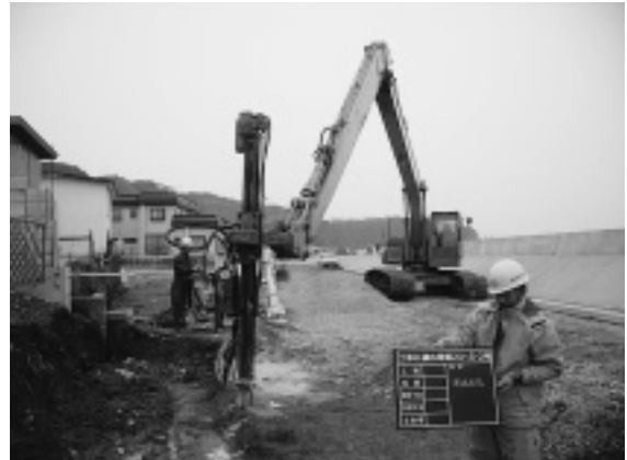
写真-1 重機械取付け式の削岩機
