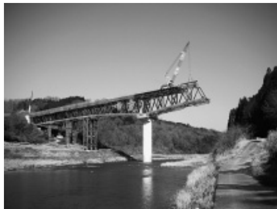
写真-3 架設状況
