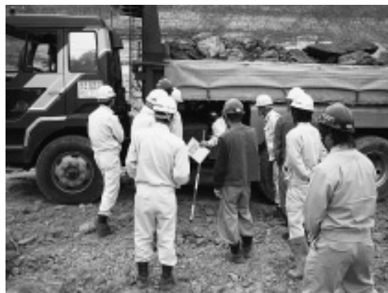
写真-7 現場での積載確認
