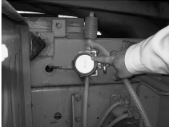
写真-8 自重計確認
