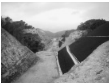
写真-1 完成写真
