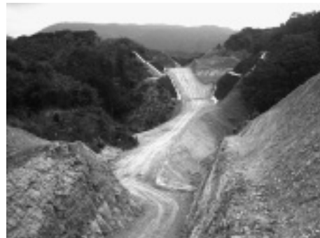
写真-2 完成写真
