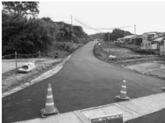
写真-3 完成写真
