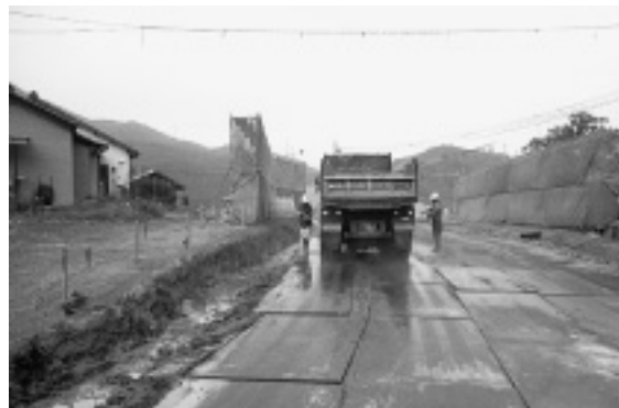
写真-5 防護壁の設置状況
