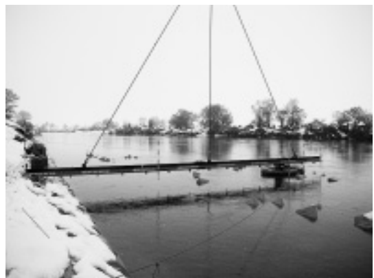
写真-1 検測状況全景
