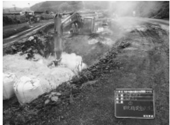
写真-2 固化材攪拌状況
