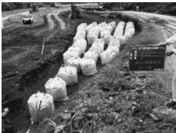
写真-1 クレーンによる固化材配置完了
