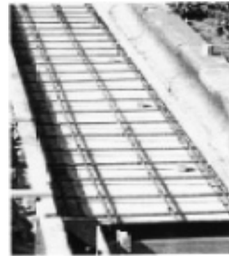
写真-1 設計の施工方法（参考写真）
