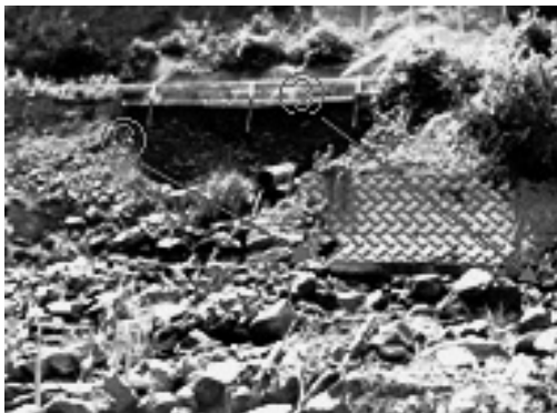
写真-1 湧水箇所全体
