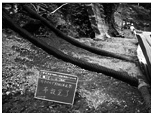
写真-4 湧水処理管大型ブロック背面湧水箇所②
