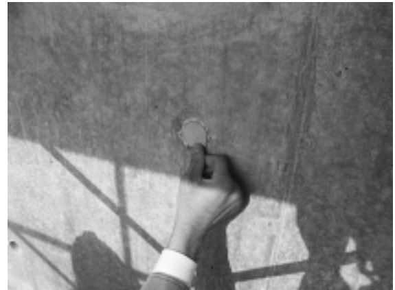
写真-4 Pコーン穴処理施工
