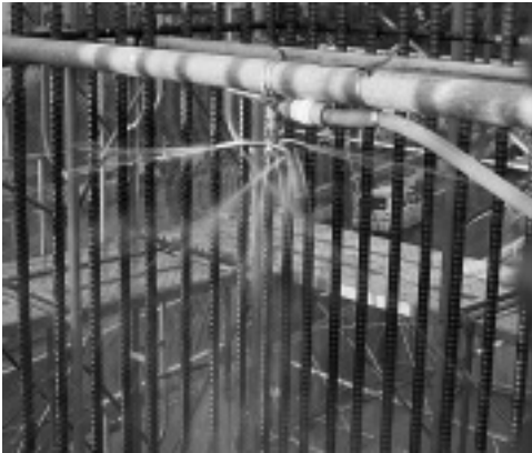
写真-6 温水養生
