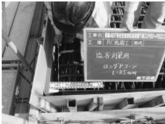
写真-2 L=85mmの長尺Pコーン
