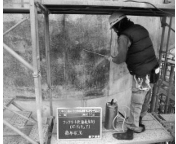
写真-8 コンクリート表面養生剤
