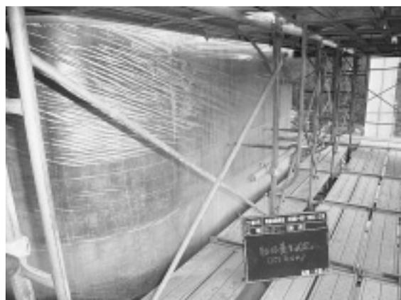
写真-5 ビニールシート養生（脱型後）
