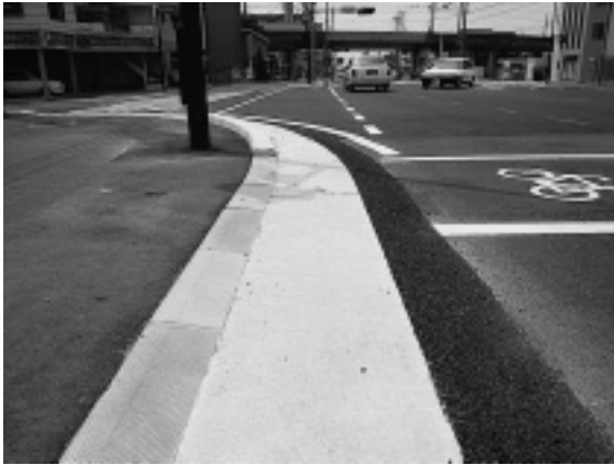
写真-2 現場打ちL型側溝
