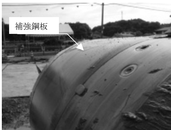
写真-2 先端部の改良(補強鋼板)
