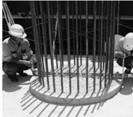
写真-3 杭径の測定
