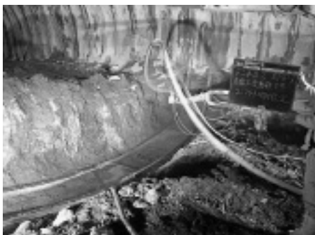
写真-3 鋼製ストラット取付状況
