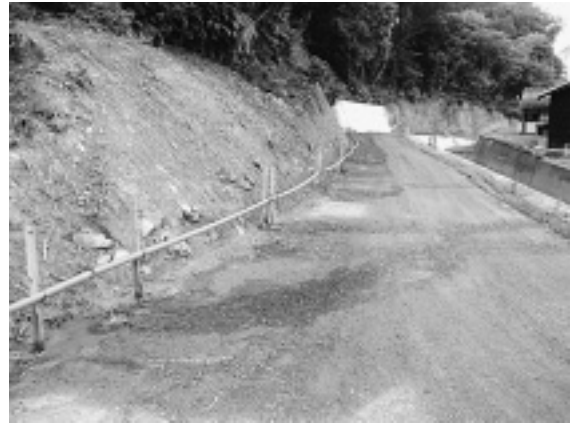
写真-3 工事用道路
