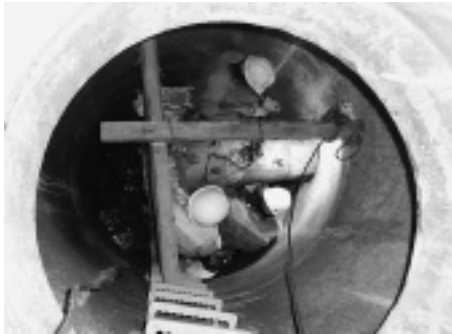
写真-2 人孔内簡易吊具設置
