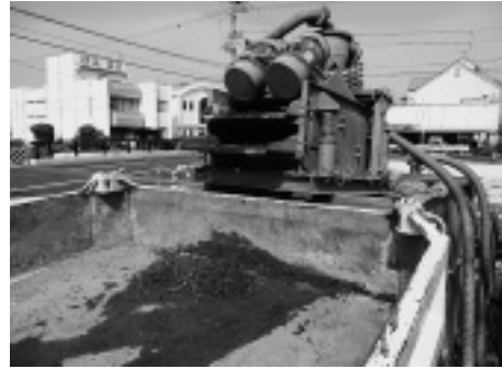
写真-4 流木搬出状況
