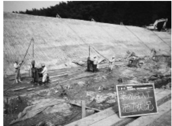
写真-1 薬液注入施工状況
