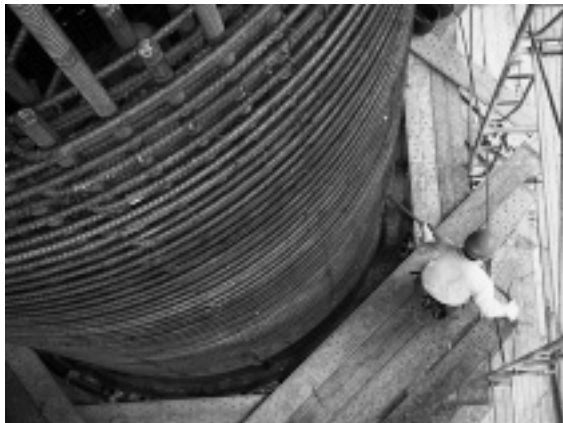
写真-1 施工状況
