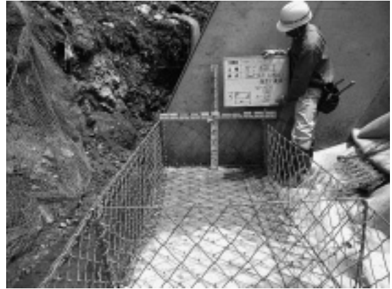
写真-2 合板型枠の使用前
