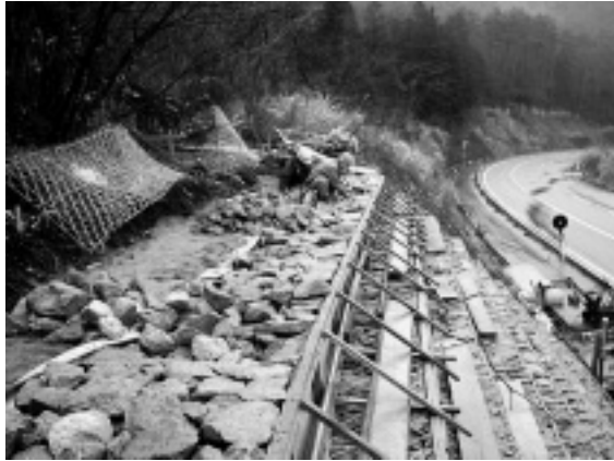
写真-1 合板型枠の使用状況
