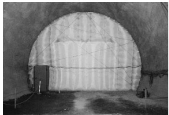
写真-1 養生用バルーン
