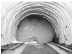
写真-4 シート養生と加熱養生
