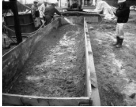
写真-3 混合水注水状況
