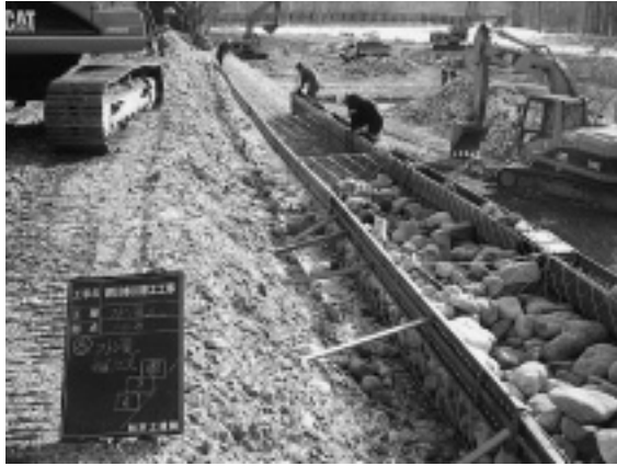
写真-2 H鋼の設置状況
