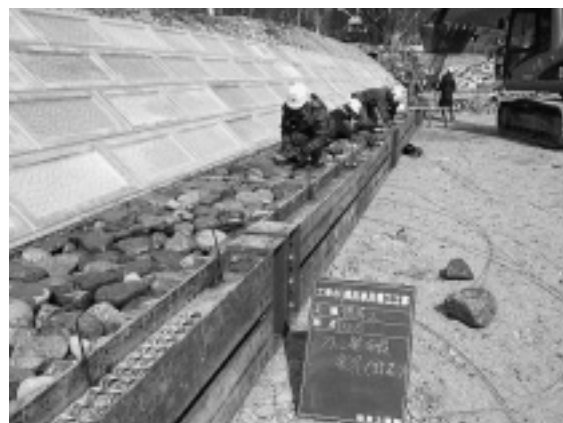
写真-1 H鋼を使用している詰石作業状況
