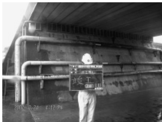
写真-1 縁端拡幅工事全景
