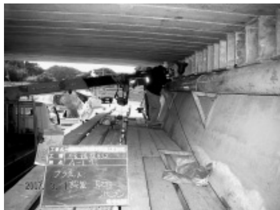
写真-2 ブラケット設置状況
