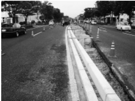
写真-2 施工状況
