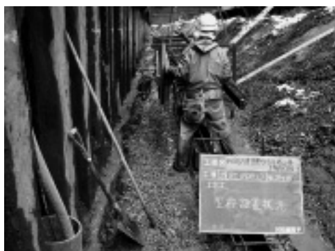
写真-2 型枠設置状況 (基礎矢板に被せるように設置)
