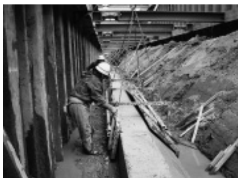
写真-3 型枠脱型状況 (ボルトを締めた後、四隅をチェーンにより固定し四隅を均等に吊り下げる。真上に吊上げると型枠が開く)
